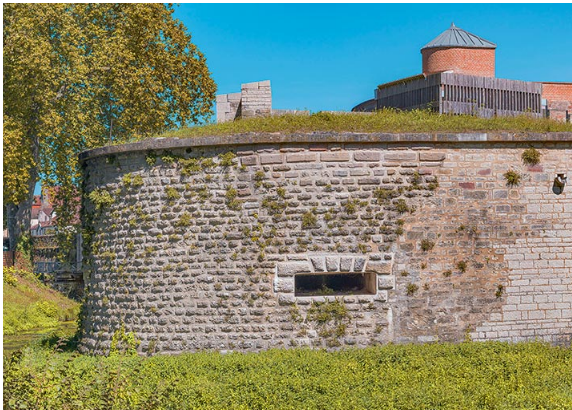
La tour basse des Moulins, vue de profil.
