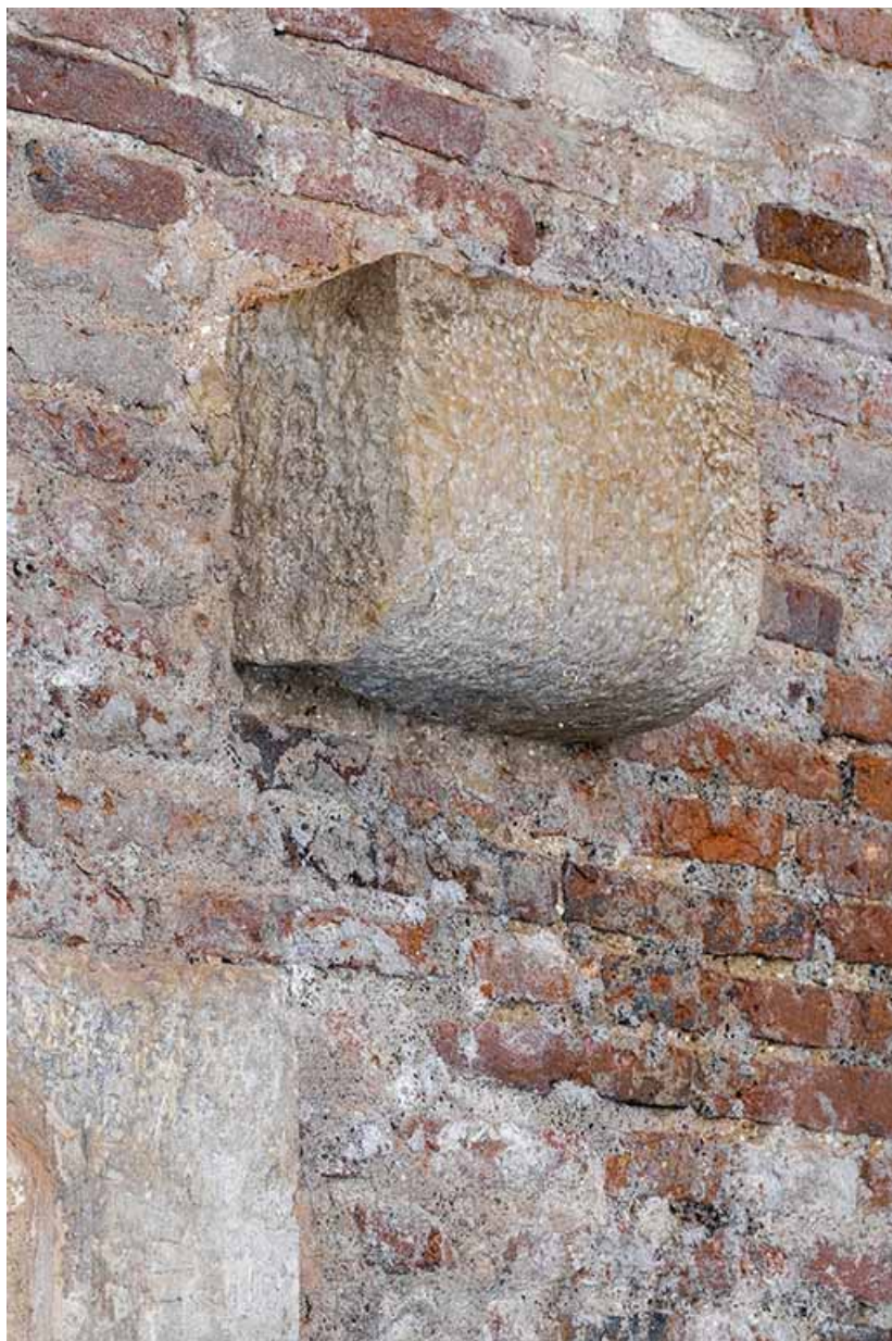
Pavillon d'entrée : corbeau situé au-dessus de la cheminée.
