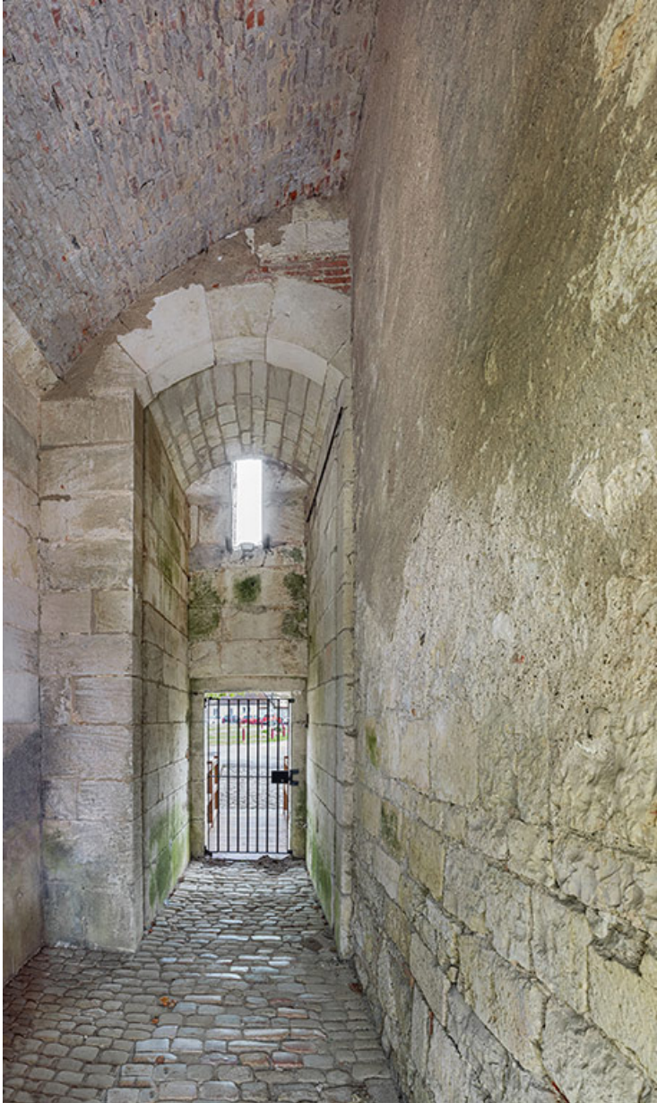
Pavillon d'entrée : passage piéton.
