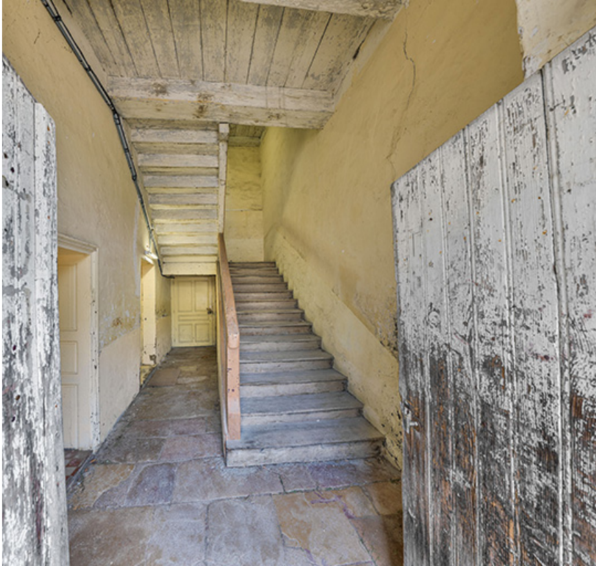
Caserne Vauban : cage d'escalier au rez-de-chaussée.
