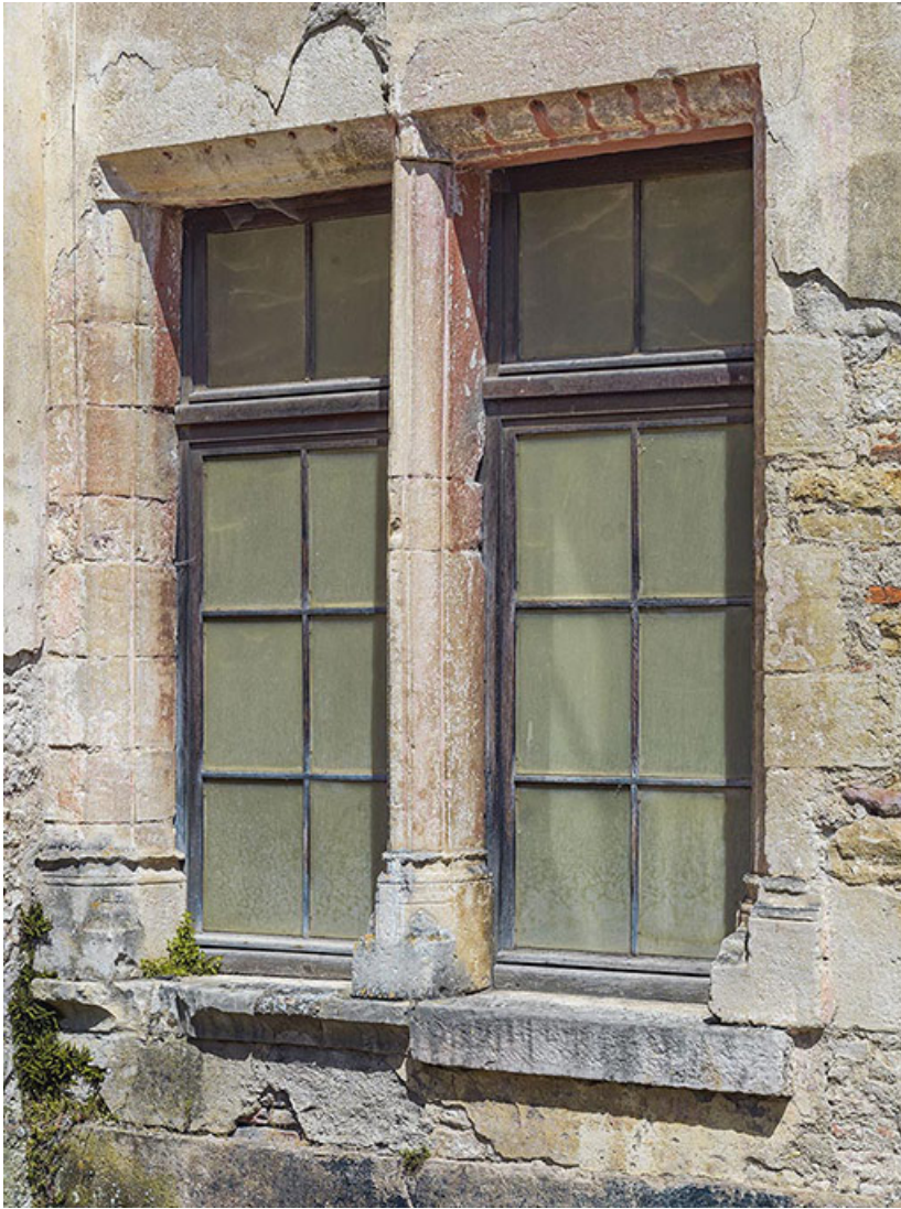
Logis du gouverneur : fenêtre à meneau.
