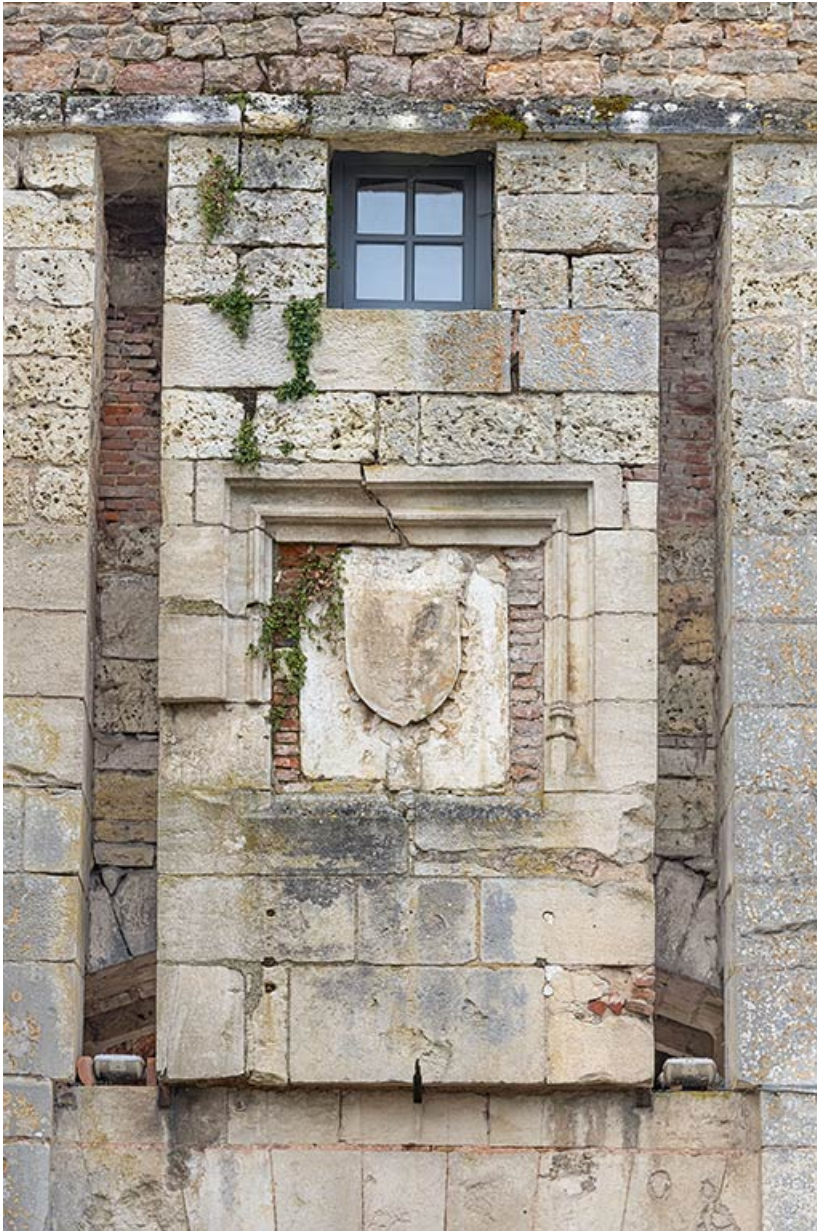
Porte côté ville : détail du blason et des rainures des flèches du pont-levis. 21, Auxonne, 1 rue du Château
