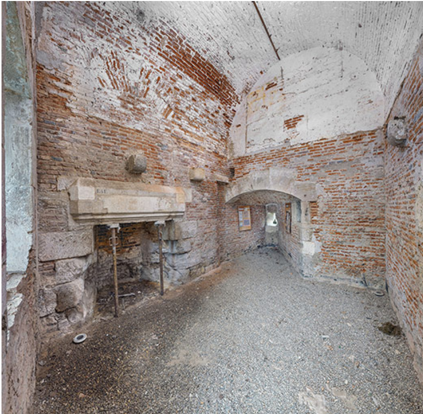
Pavillon d'entrée et son corps de garde : vue d'ensemble.
