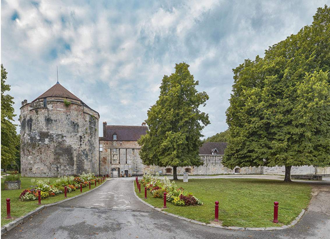
Entrée principale du château : vue d'ensemble.
