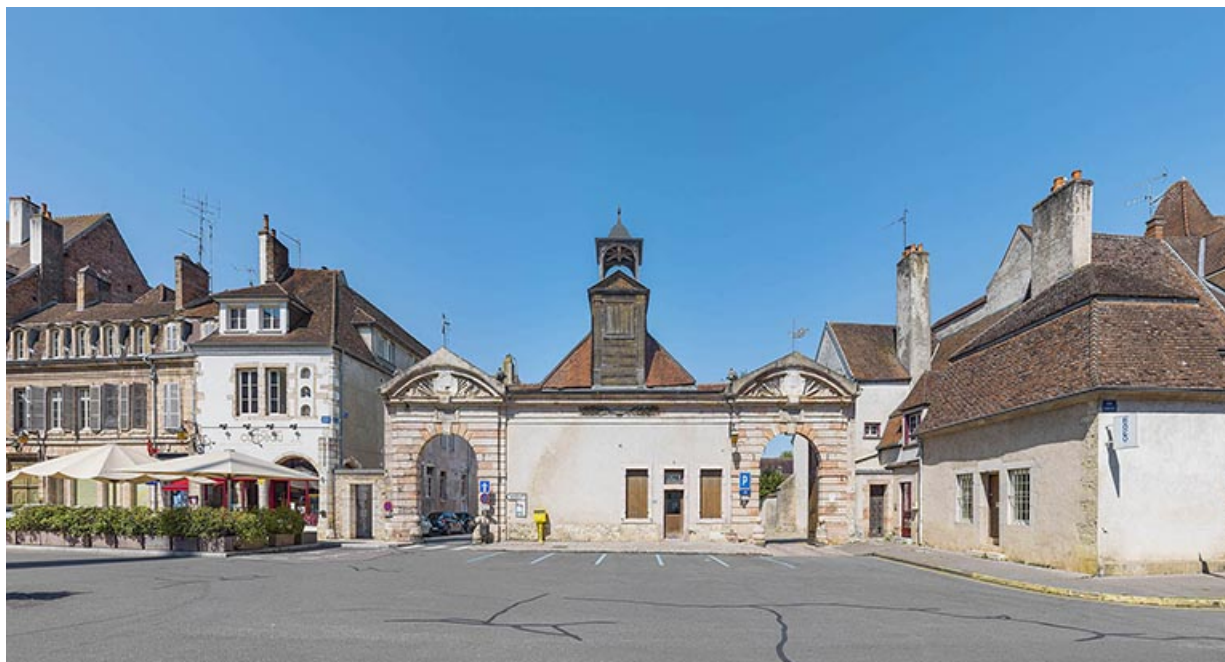
Vue d'ensemble depuis la rue Carnot.
