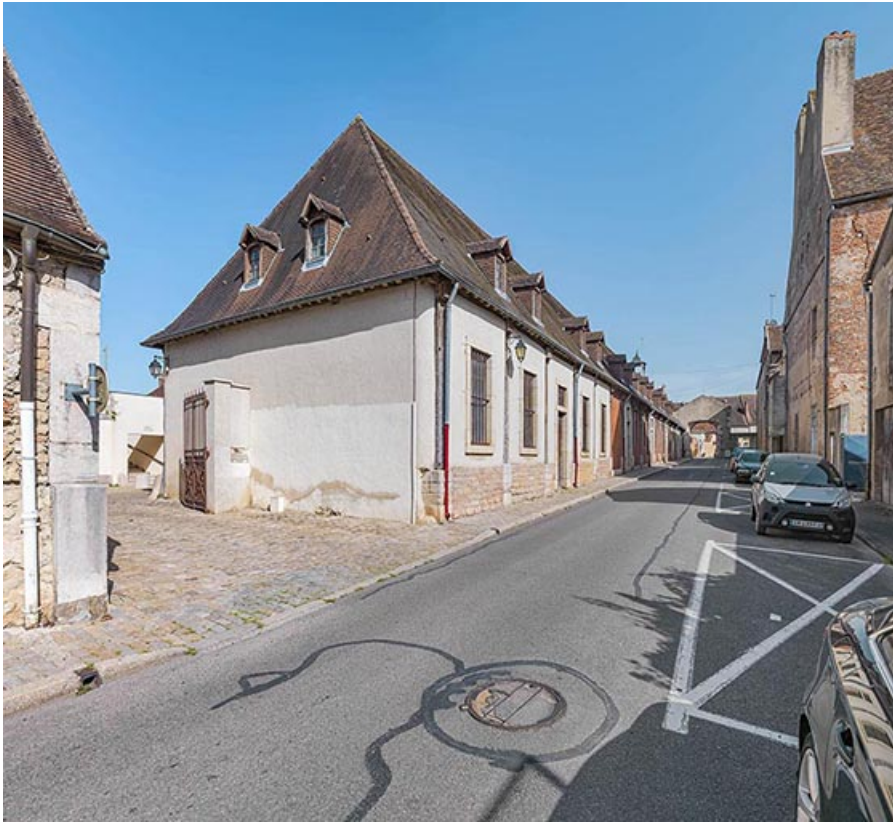
Le hangar depuis la rue des Halles.
