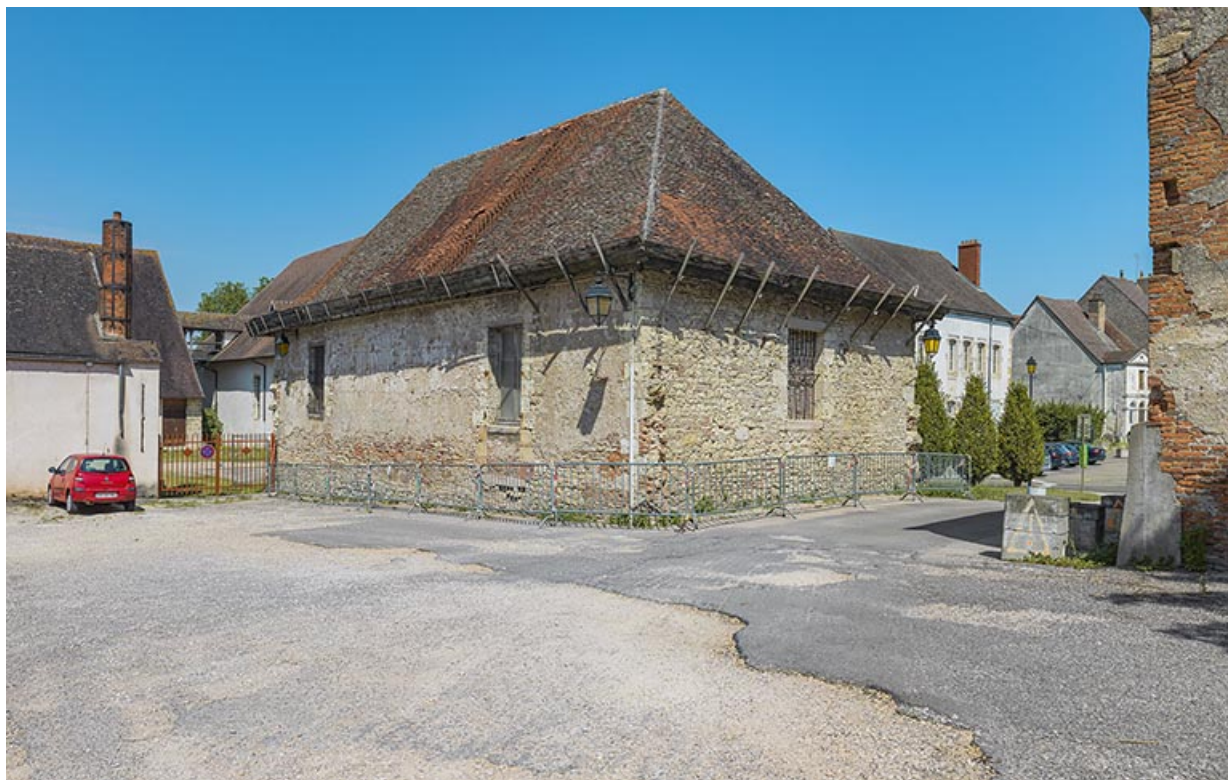
Les petites forges, vue de trois quarts depuis le parking du même nom. 21, Auxonne rue des Halles
