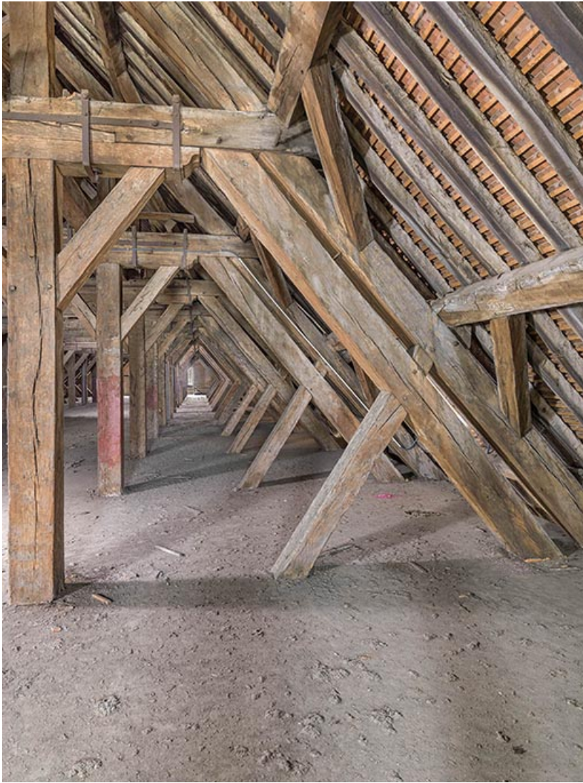
Détail de la charpente à chevrons-portant-fermes.
