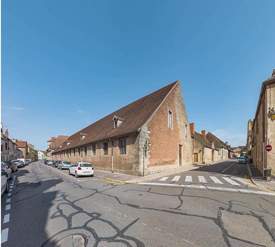
Les grandes halles depuis la rue Vauban. 21, Auxonne rue des Halles
