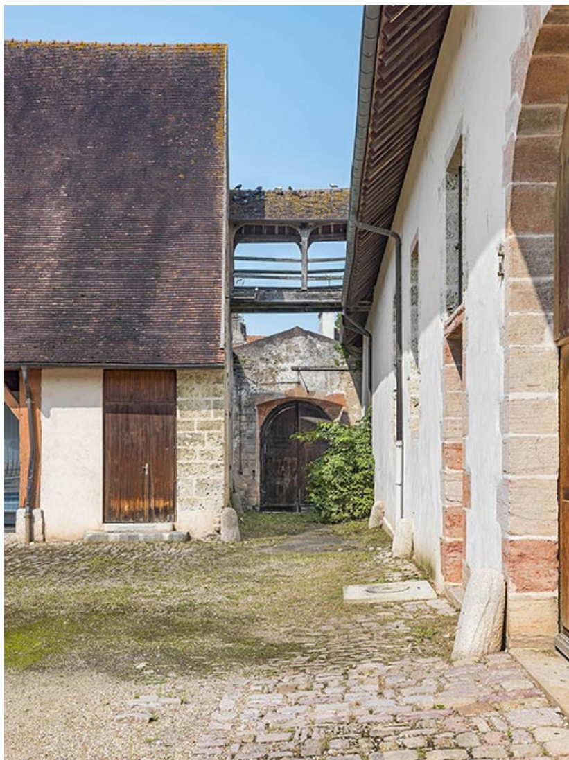
La passerelle reliant la grande halle et les grandes forges.
