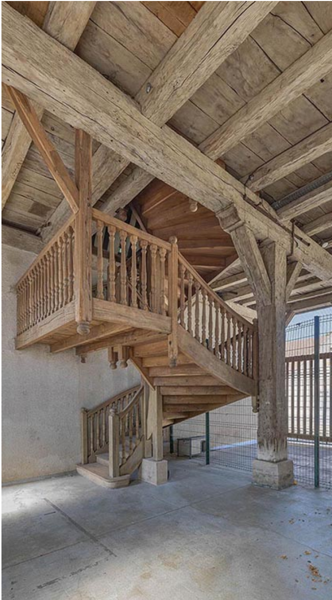
Escalier desservant l'étage supérieur du hangar.
