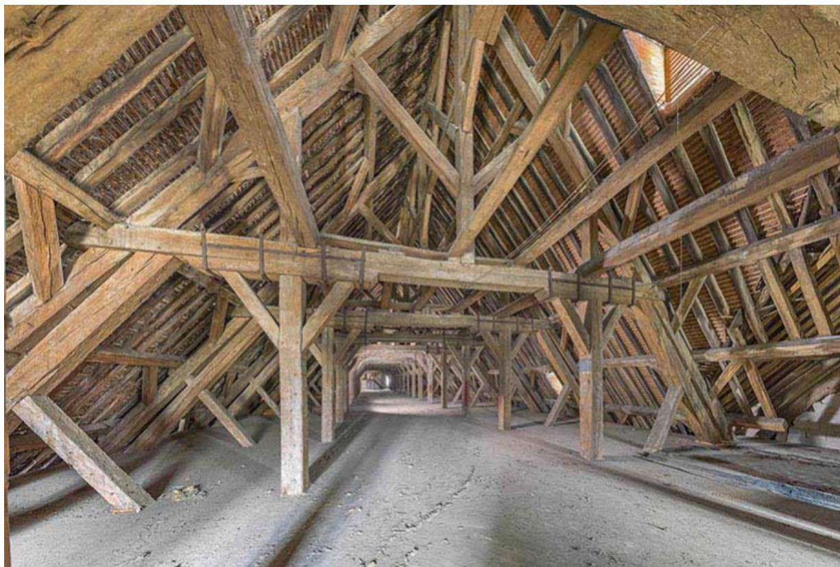
Charpente des grandes halles.
