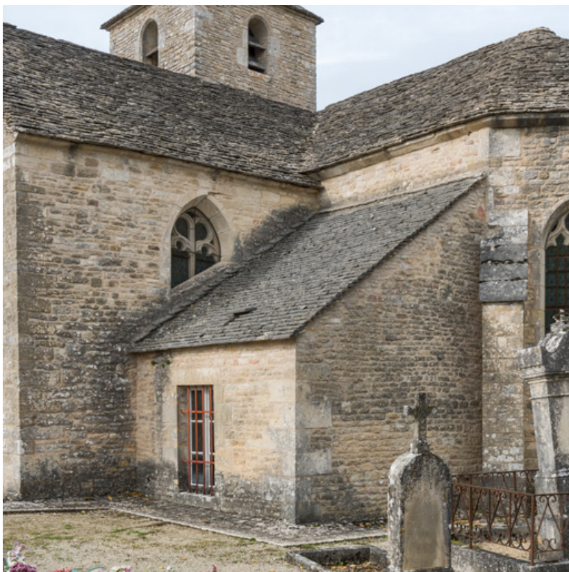
Détail de la toiture côté nord.
