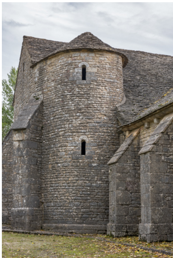
Tourelle d'escalier côté nord.
