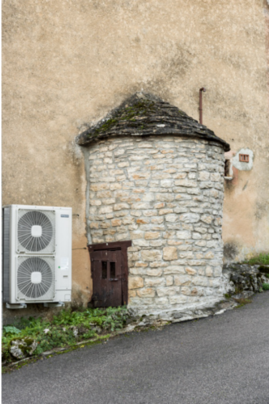
Vue du four à pain côté nord-ouest.
