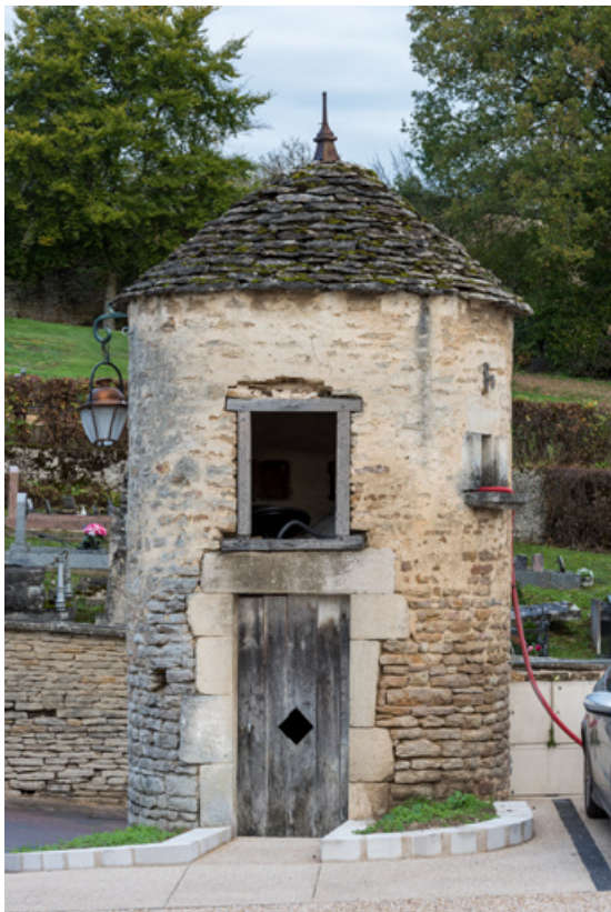
Vue d'ensemble côté sud.
