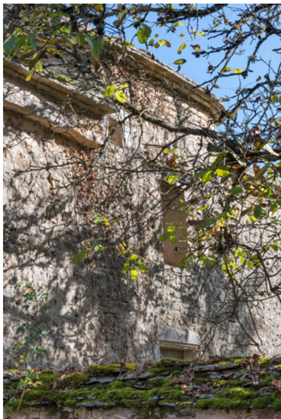
Rempart entrée ouest. 21, Salives rue d' Amont
