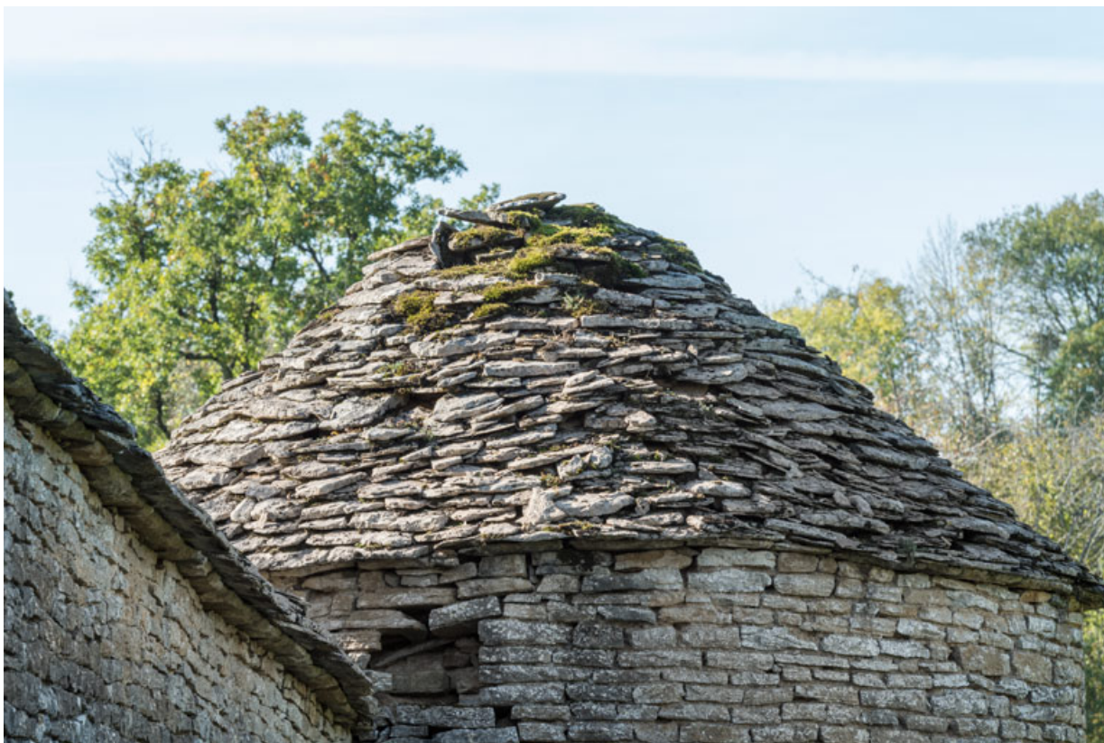
Détail de la toiture tour sud.
