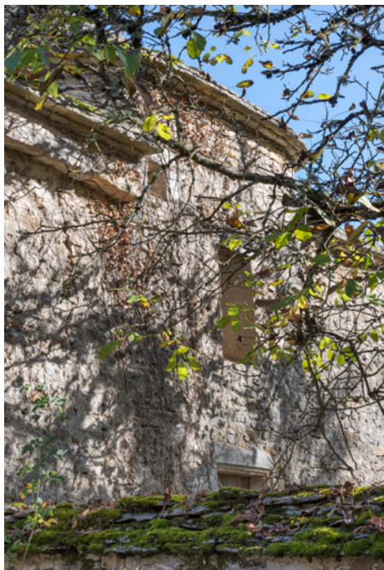
Rempart entrée ouest. 21, Salives rue d' Amont
