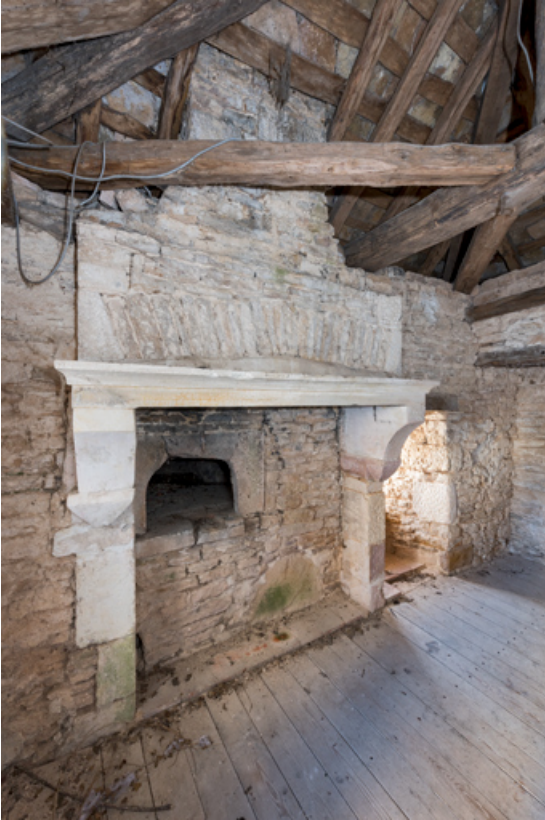
Vue intérieure de la cheminée et de la gueule du four. 21, Salives rue d' Amont
