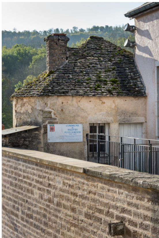
Vue d'ensemble depuis le sud.
