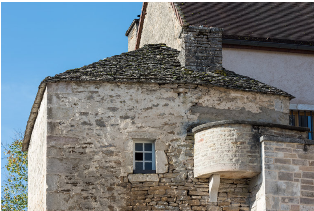
Vue de la toiture depuis l'ouest.
