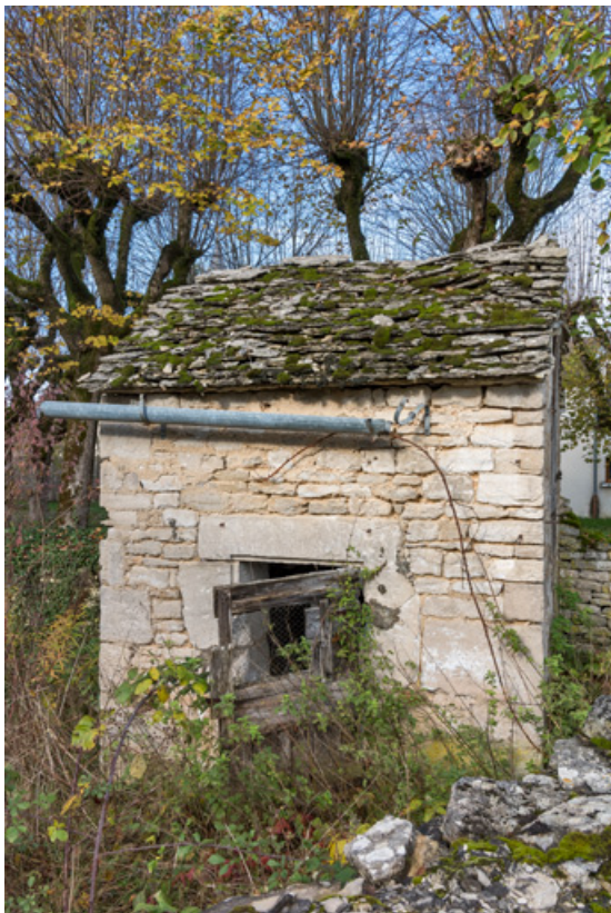
Vue de la façade sud.
