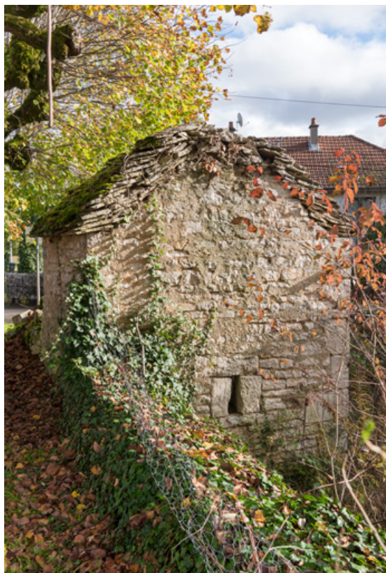
Vue de la façade ouest.
