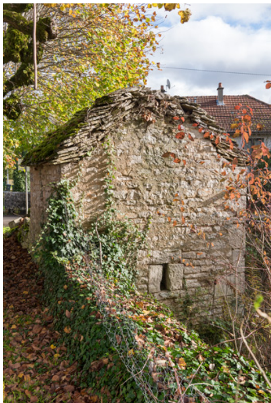
Vue de la façade ouest.
