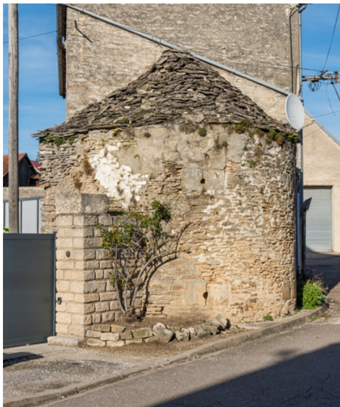
Vue de la tour depuis le sud-ouest.
