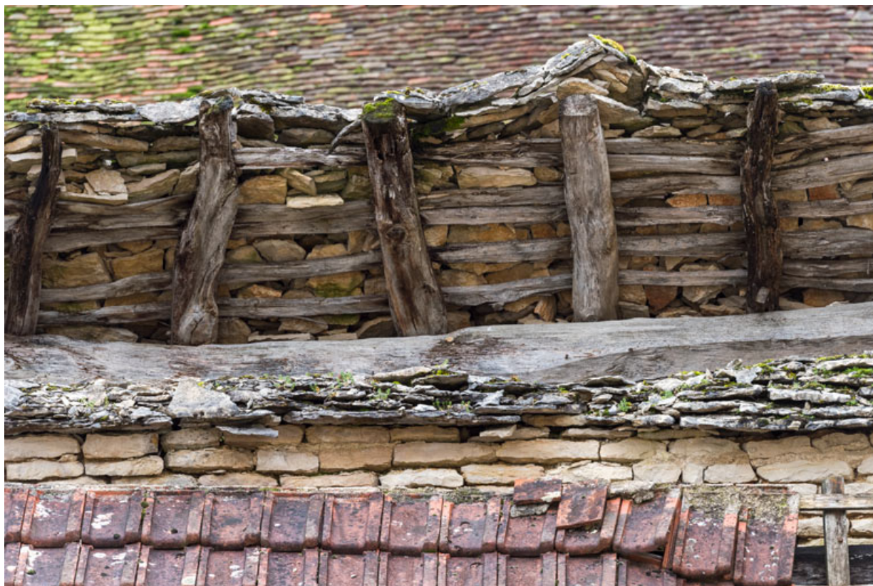
Détail de la toiture côté est.
