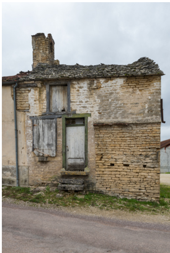
Vue de la façade ouest.
