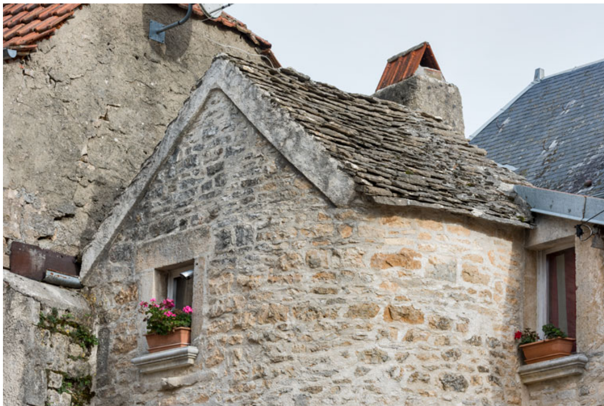
Détail de la toiture côté nord-ouest.
