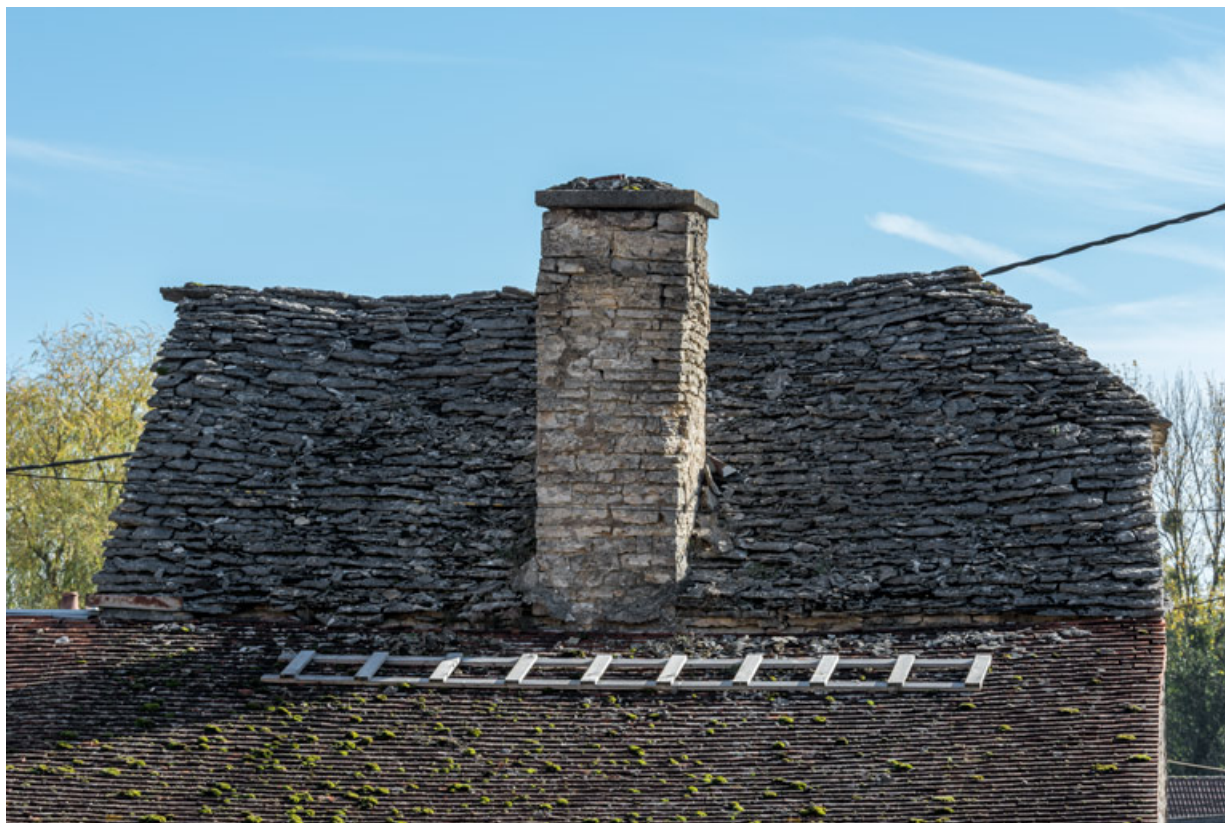
Détail de la toiture et de la souche de cheminée côté ouest.
