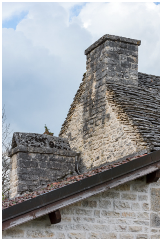
Détail de la toiture et de la souche de cheminée.
