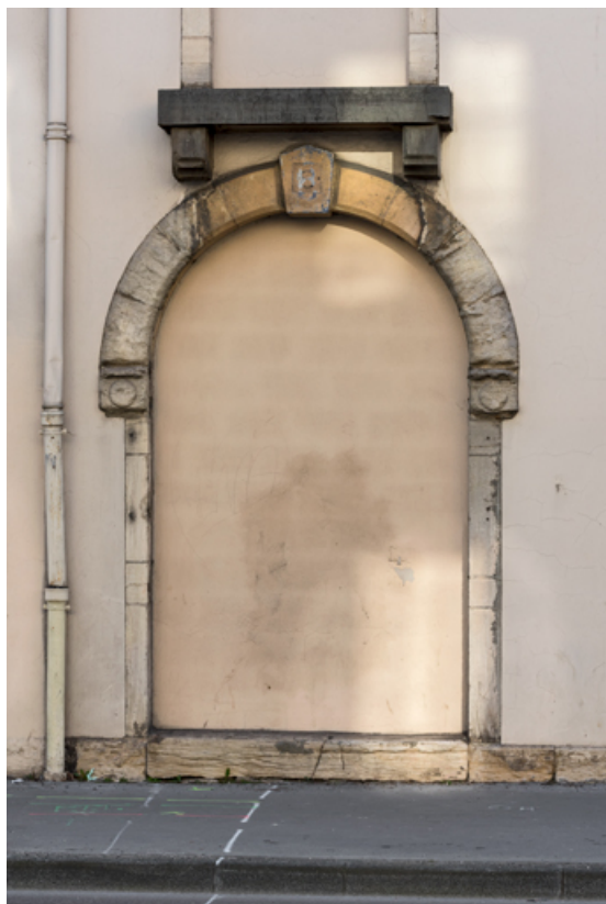
Cinéma Devosge, façade antérieure : porte murée. 21, Dijon
