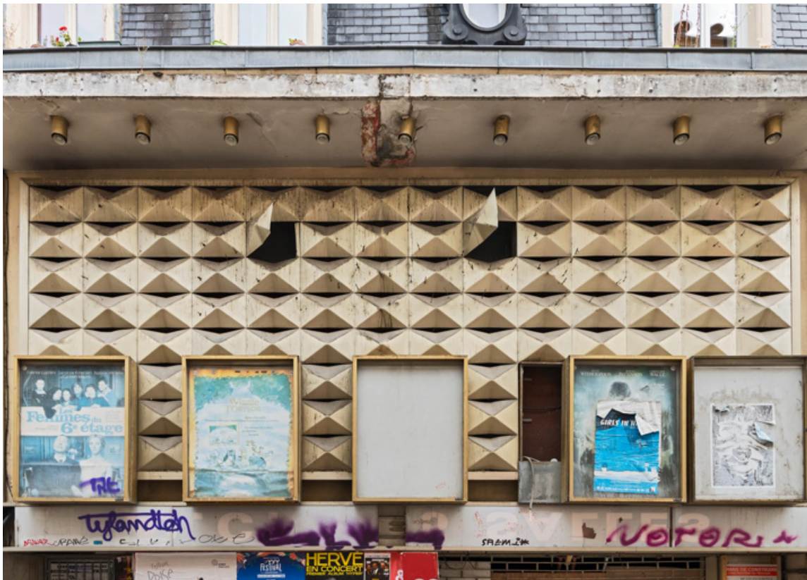
Cinéma ABC, façade antérieure : décor métallique sous l'auvent. 21, Dijon
