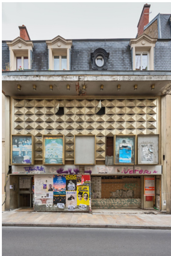
Cinéma ABC : façade antérieure. 21, Dijon
