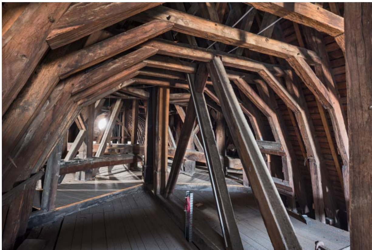
Comble : vue prise depuis le chevet oriental.
