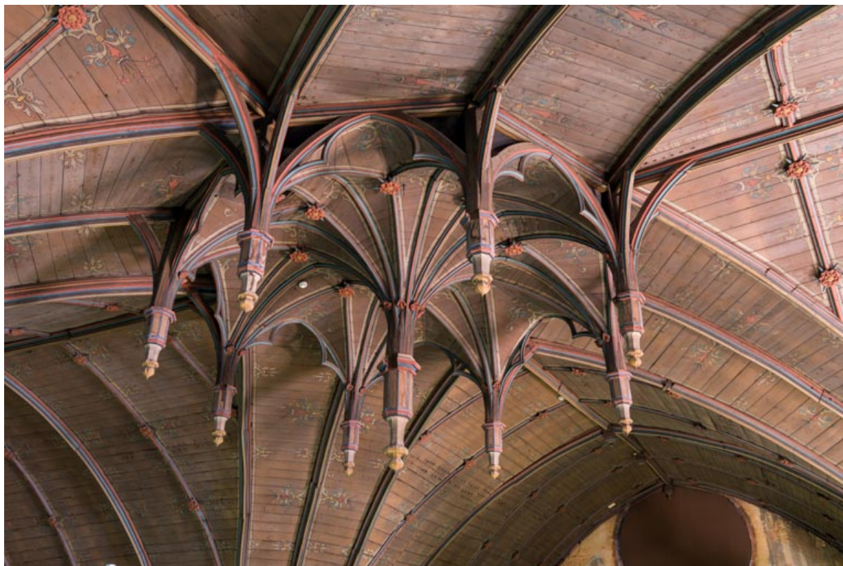
Croisée du transept, charpente lambrissée : décor de clés pendantes. 21, Dijon, 15 rue Danton
