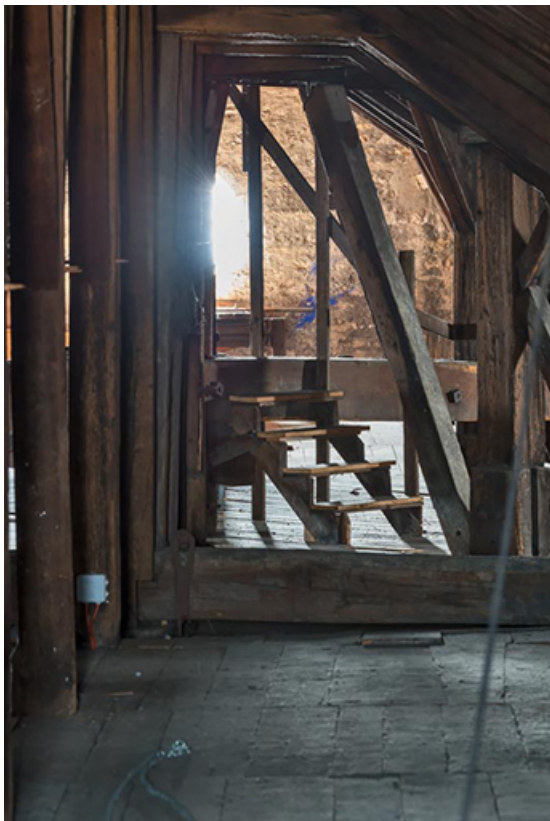
Comble : croisée du transept, avec le chevet oriental au fond.
