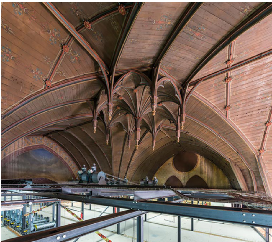
Croisée du transept : charpente lambrissée.
