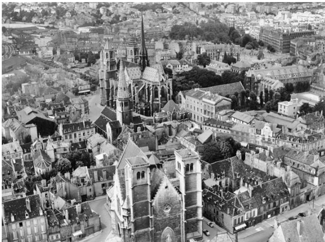
[Vue aérienne du quartier avec l'église Saint-Jean au premier plan]. S.d. [entre 1945 et 1975]. 21, Dijon, 15 rue Danton
