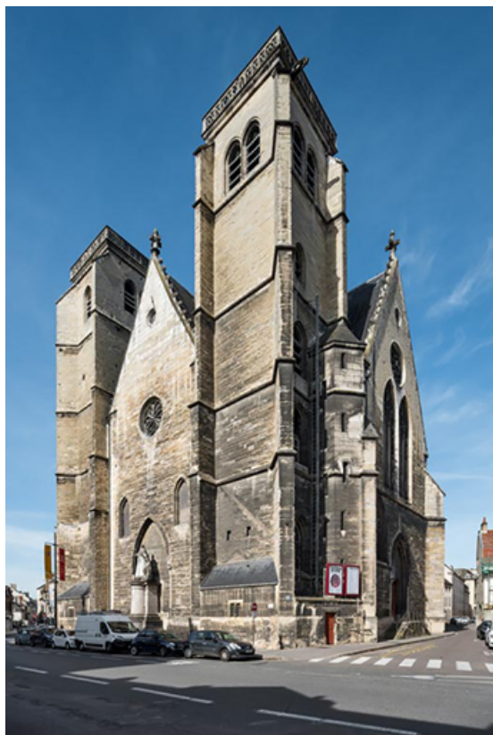
Façade orientale et tours.
