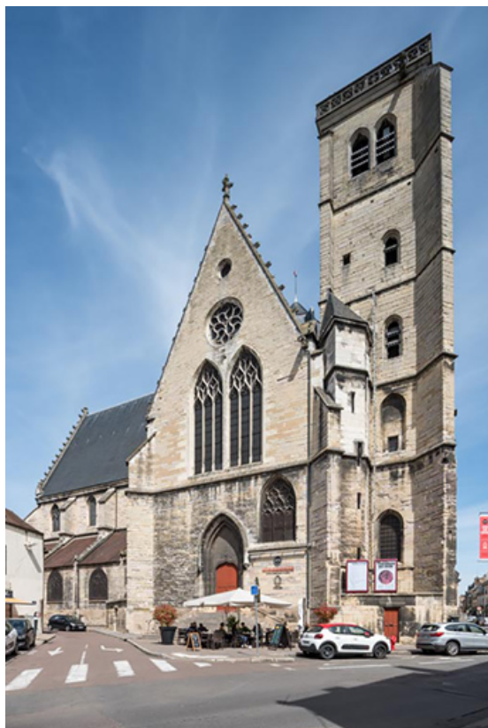
Façade sud, de trois quarts droite : extrémité du transept et tour. 21, Dijon, 15 rue Danton
