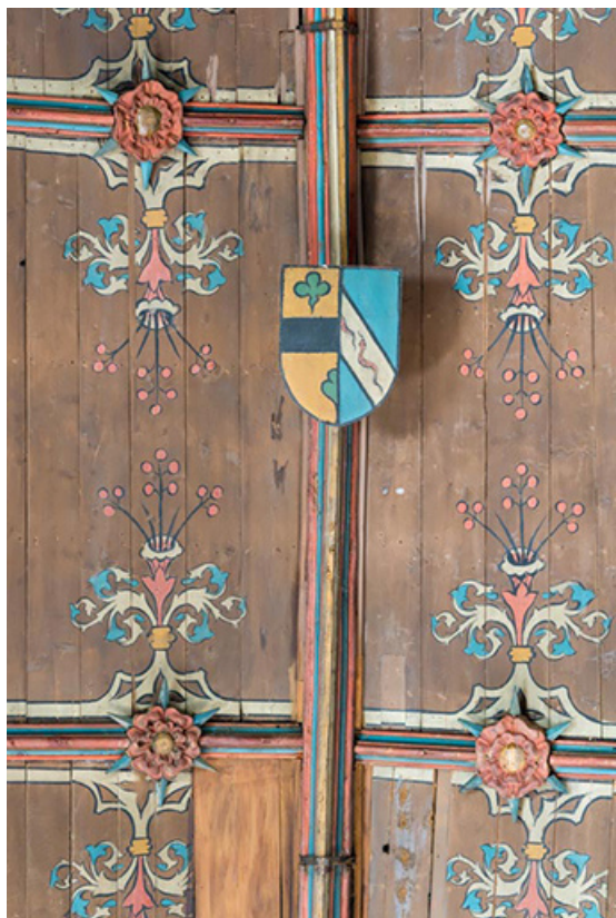
Décor peint de la charpente lambrissée.
