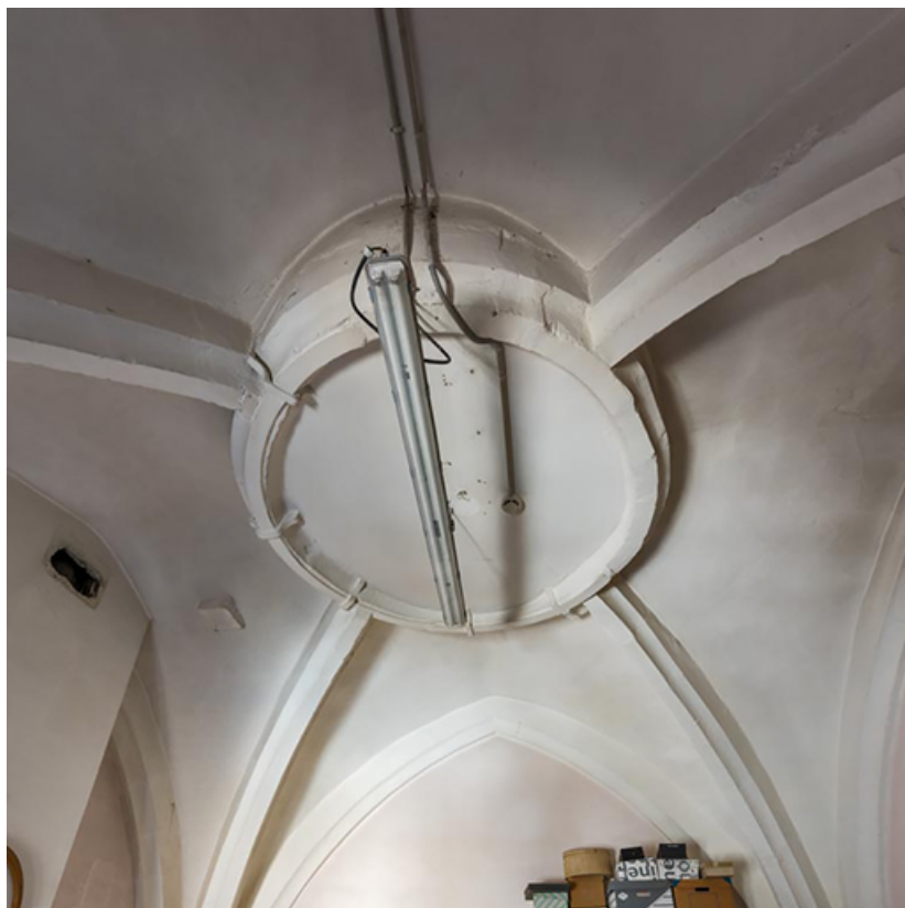
Tour nord, premier étage : voûte d'arêtes avec ouverture zénithale (bouchée). 21, Dijon, 15 rue Danton
