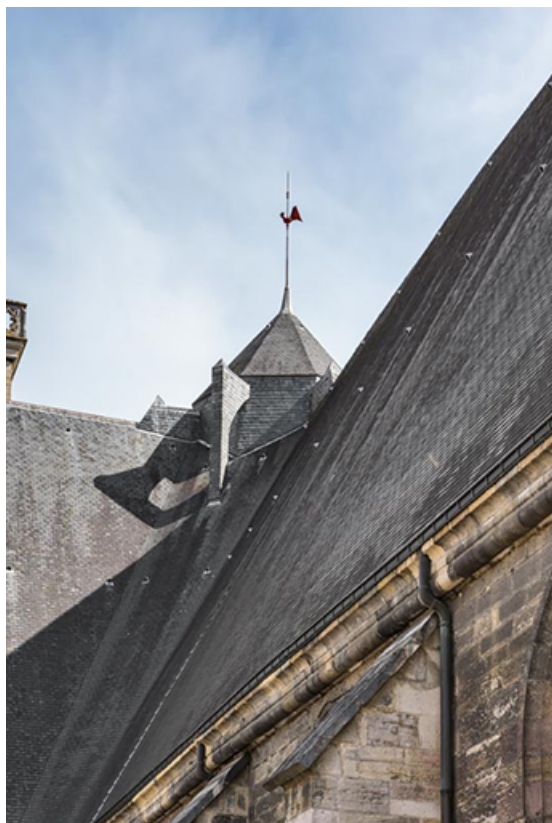
Toit polygonal marquant l'emplacement de la flèche à la croisée du transept, vu du nord-ouest. 21, Dijon, 15 rue Danton
