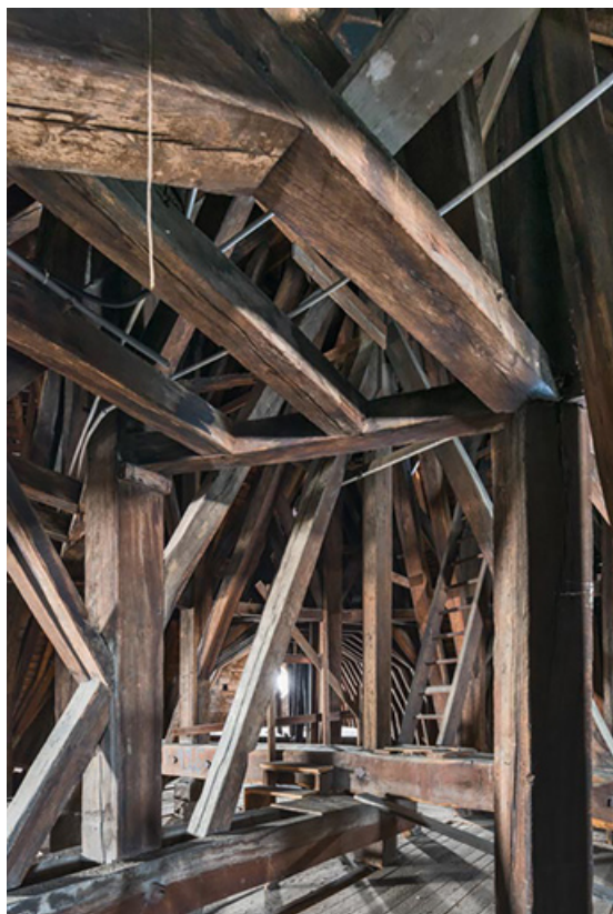
Comble : croisée du transept depuis le bras nord. 21, Dijon, 15 rue Danton
