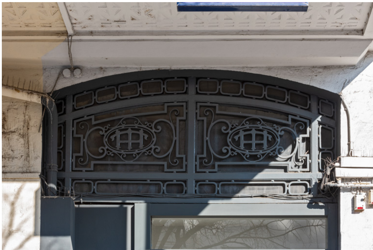
Façade latérale droite : ferronnerie à l'entrée de l'hôtel, avec le monogramme HT (Hôtel Terminus). 21, Dijon, 22-26 avenue du Maréchal Foch
