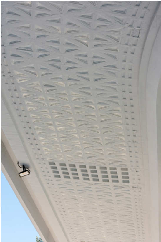
Face inférieure de l'auvent en béton armé.
