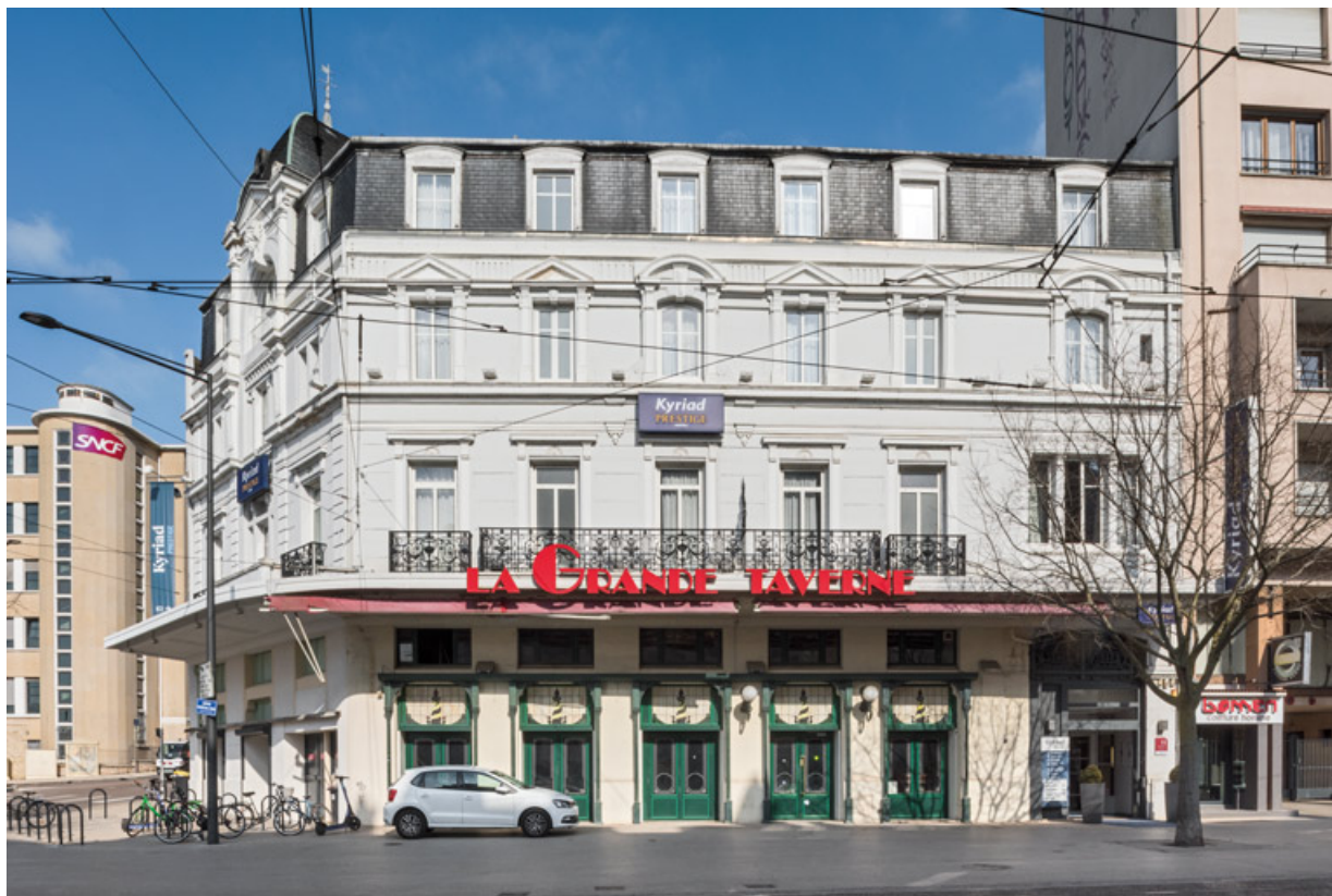
Façade latérale droite (sur la rue Maréchal Foch).
