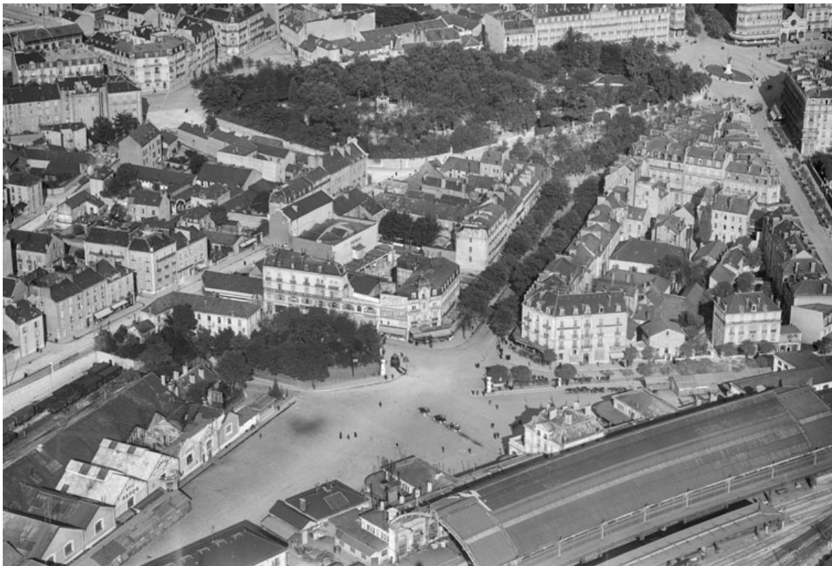
[Vue aérienne oblique du quartier de la gare, depuis le sud-ouest]. 21 septembre 1919. 21, Dijon, 17-19 rue des Perrières
