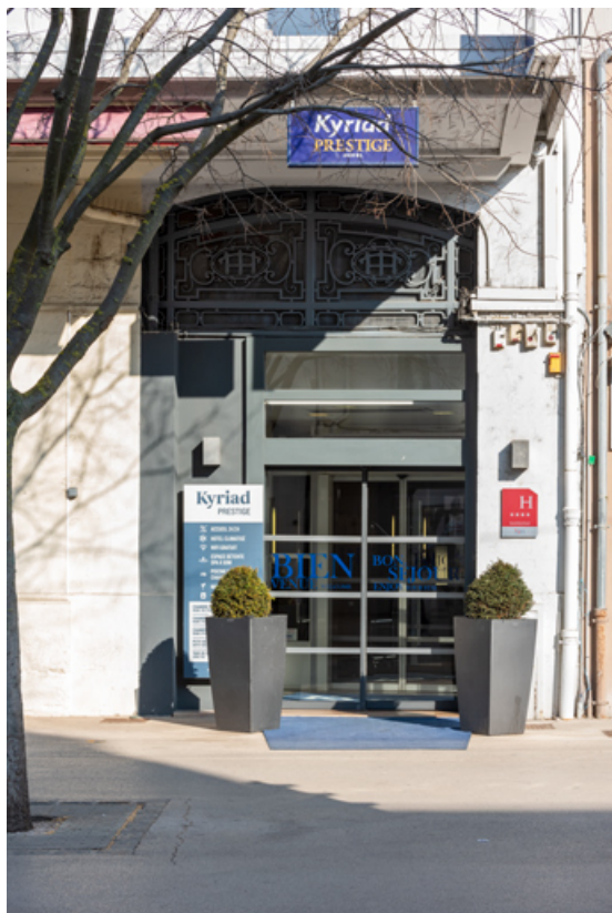
Façade latérale droite : entrée de l'hôtel. 21, Dijon, 22-26 avenue du Maréchal Foch
