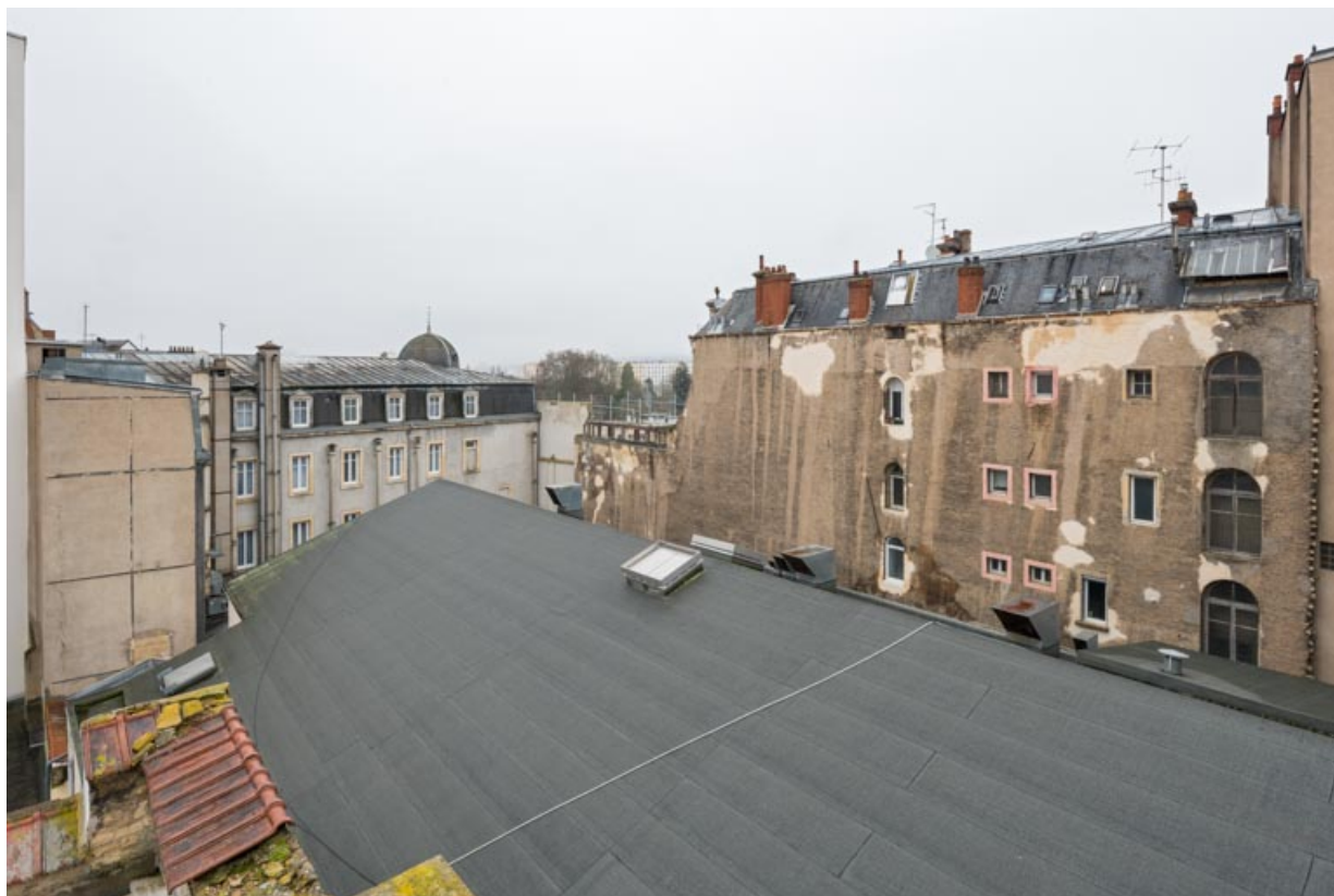
Vue d'ensemble, depuis le nord (bâtiment de la rue des Perrières) : façade postérieure au second plan (et toiture de la salle 2 au premier plan).
