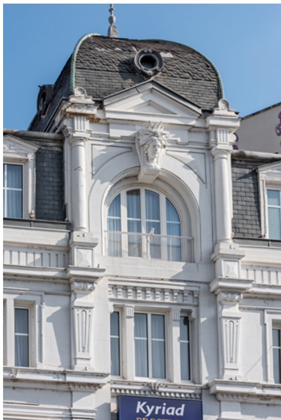
Façade antérieure : partie supérieure de la travée centrale.
