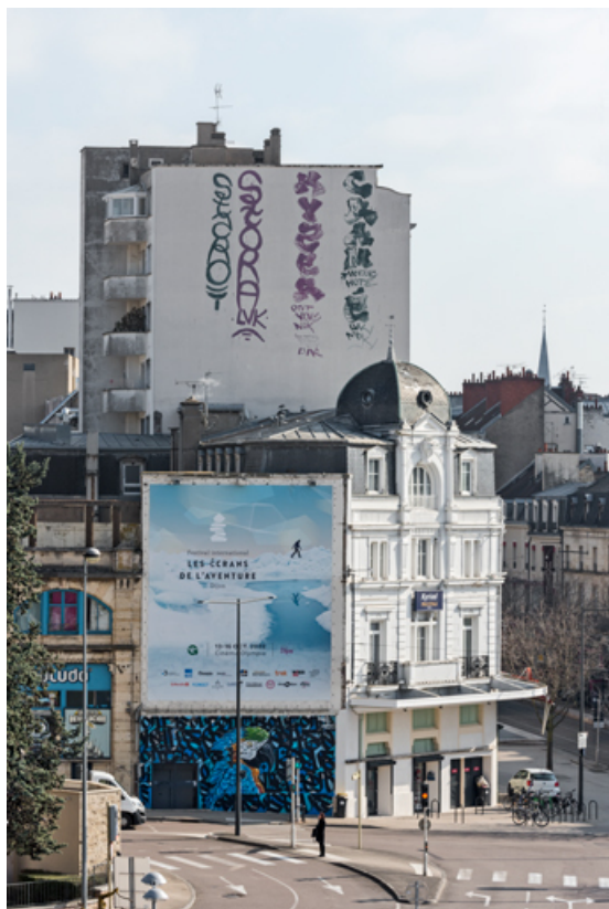
Vue d'ensemble, depuis l'ouest (cadrage vertical). 21, Dijon, 22-26 avenue du Maréchal Foch
