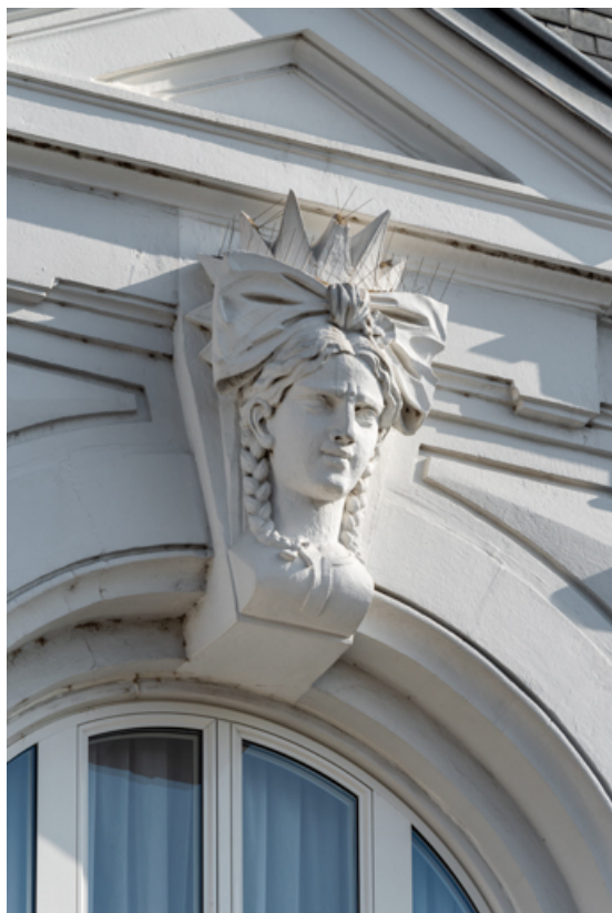
Façade antérieure, travée centrale : tête d'Alsacienne.
