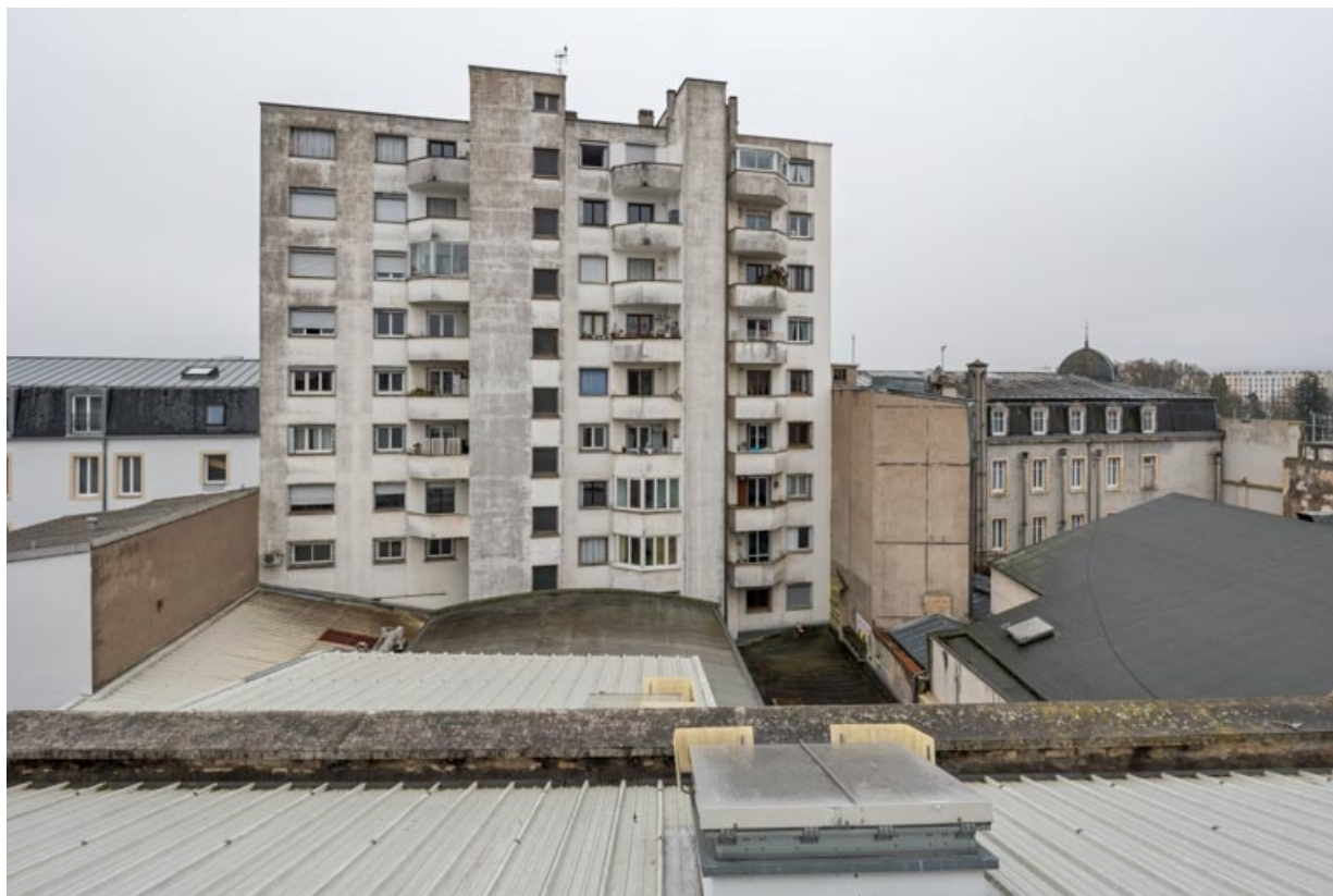
Immeuble rue Maréchal Foch : façade postérieure, vue depuis le bâtiment d'origine rue des Perrières. Entre les deux, la salle 3 à gauche et la salle 2 à droite.
