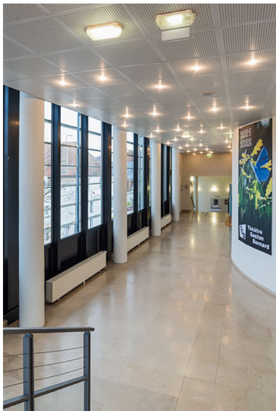
Couloir desservant la salle et le foyer, vu depuis ce dernier (le palier de l'escalier principal se trouve au fond). 21, Châtillon-sur-Seine place du 8 Mai
