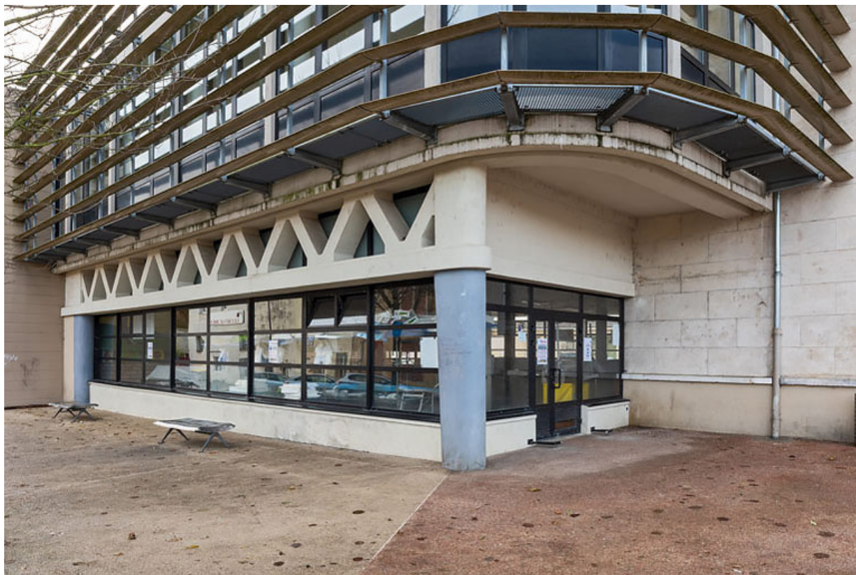
Façade latérale gauche : baies du marché.
