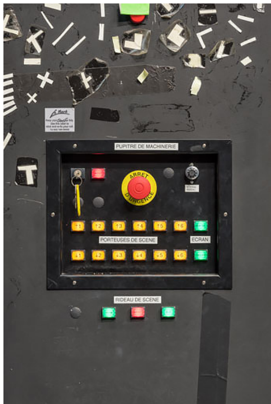
Pupitre de commande de la machinerie.
