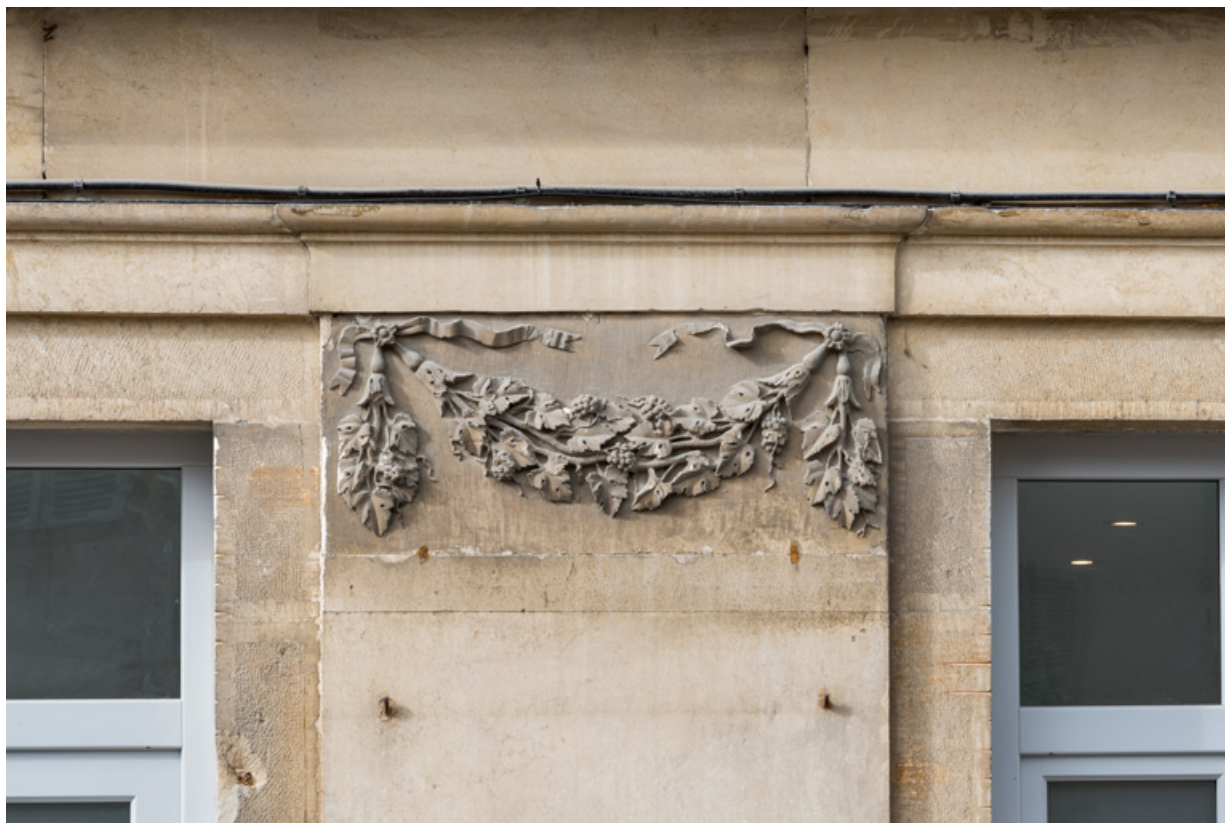
Façade antérieure, 5e pilastre (en partant de la gauche) : guirlande sculptée. 21, Semur-en-Auxois, 11 place de l' Ancienne Comédie
