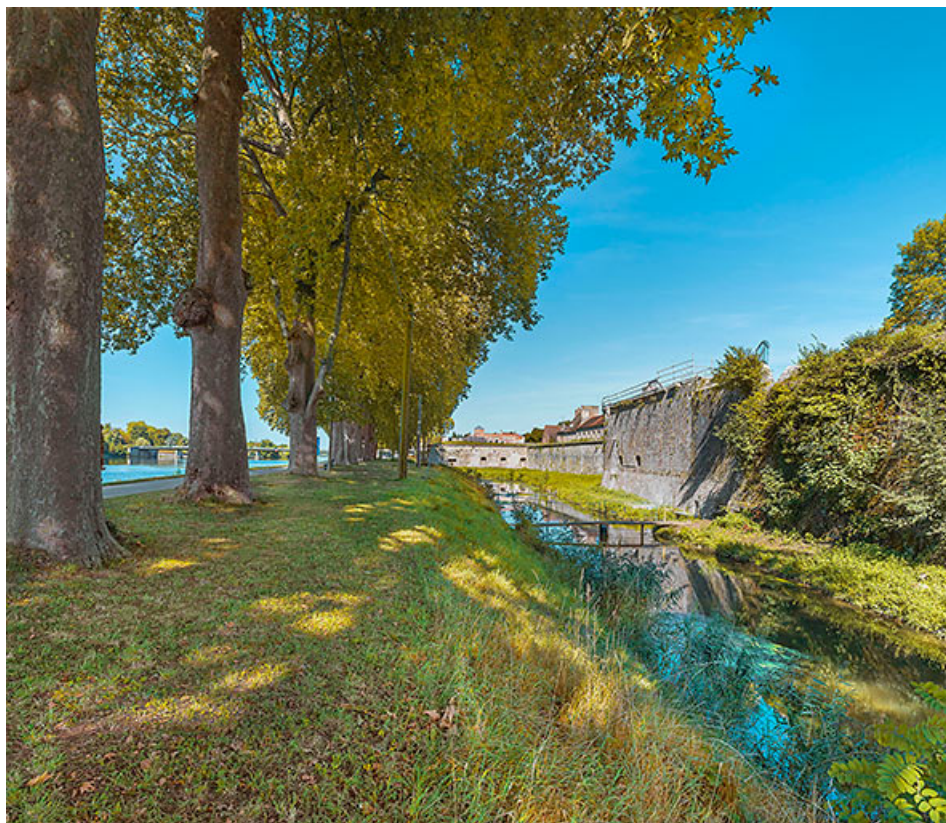
Le front de Saône au niveau du château et son fossé.
