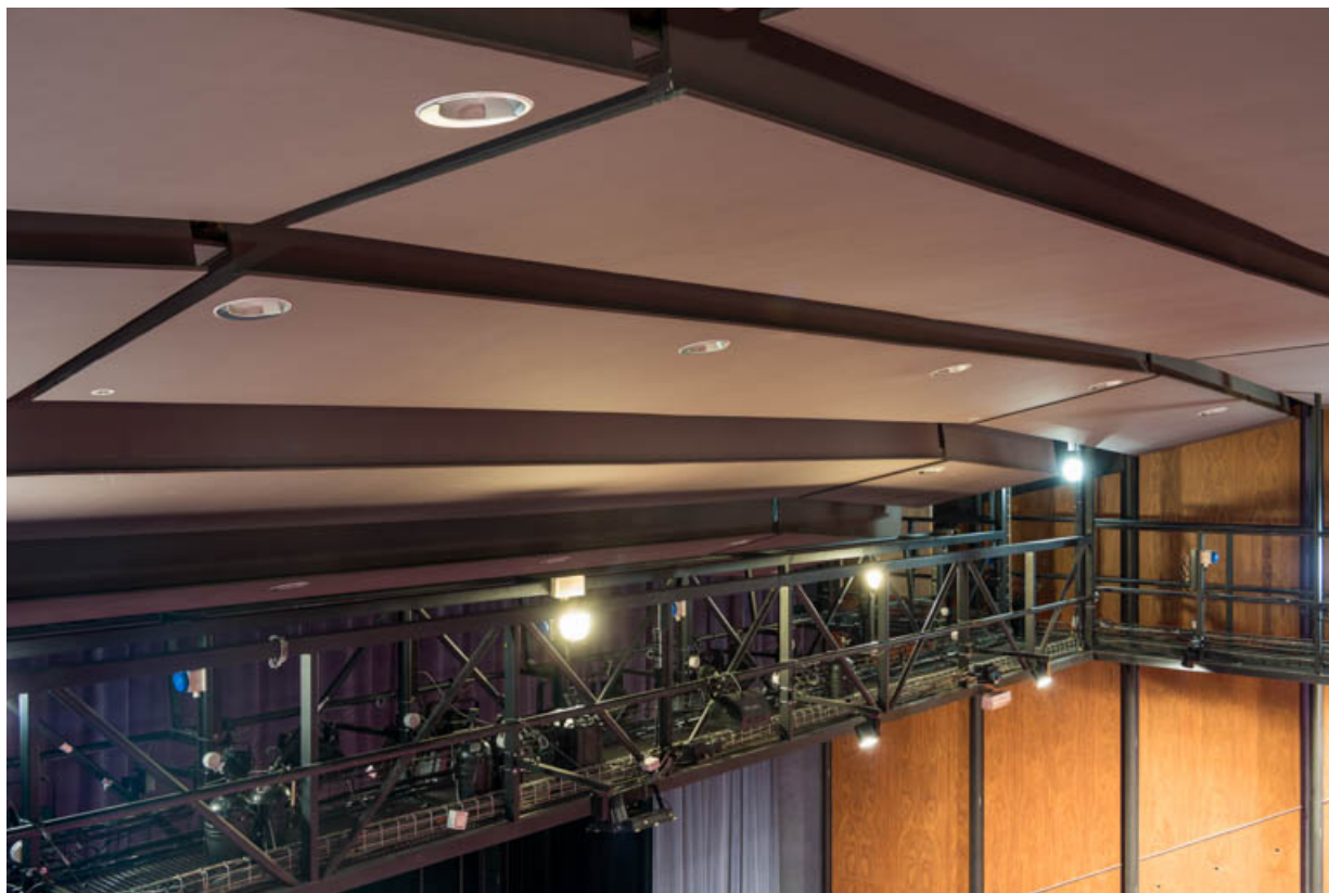
Salle : passerelle et plafond abat-son.
