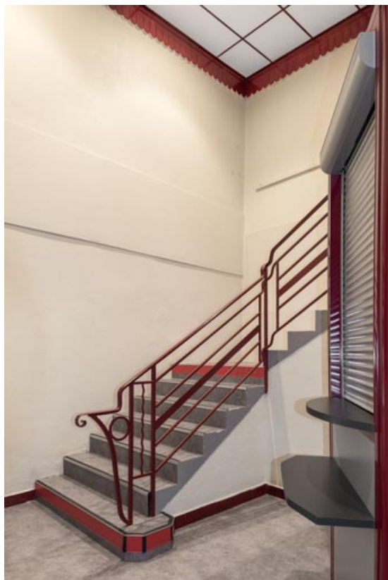
Hall d'entrée : escalier desservant le balcon. 21, Auxonne boulevard Pasteur
