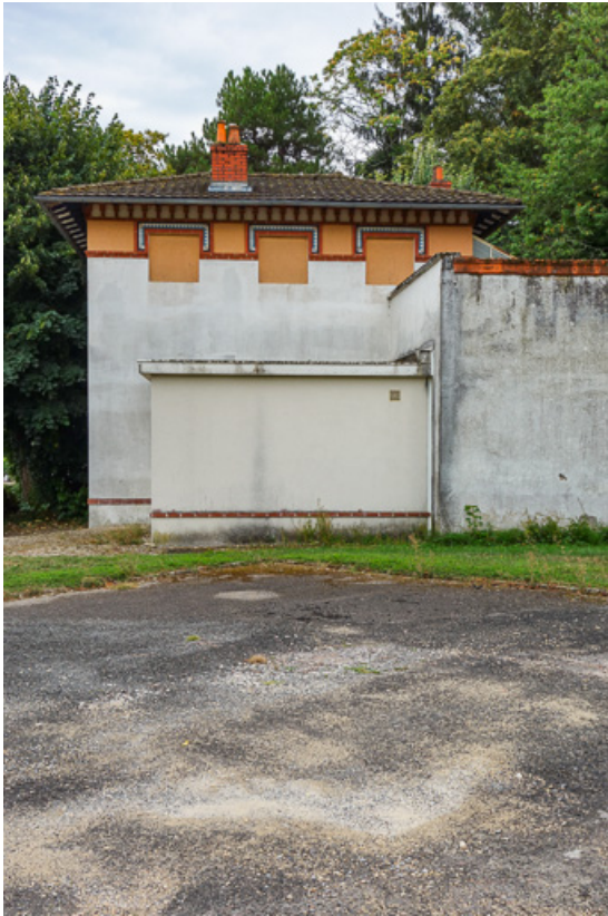
Emplacement du pavillon de la source (détruit et remplacé par une construction tardive). 21, Santenay avenue des Sources
