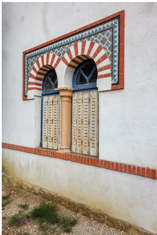
Élévation du pavillon du gardien, baies jumelées du rez-de-chaussée. 21, Santenay avenue des Sources
