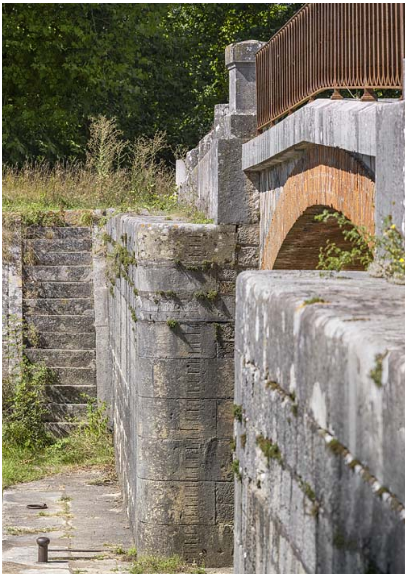
Détail de la voûte en brique, du garde-corps du pont et de l'échelle de crue sur la culée. 21, Trugny, lieu-dit : PK 184
