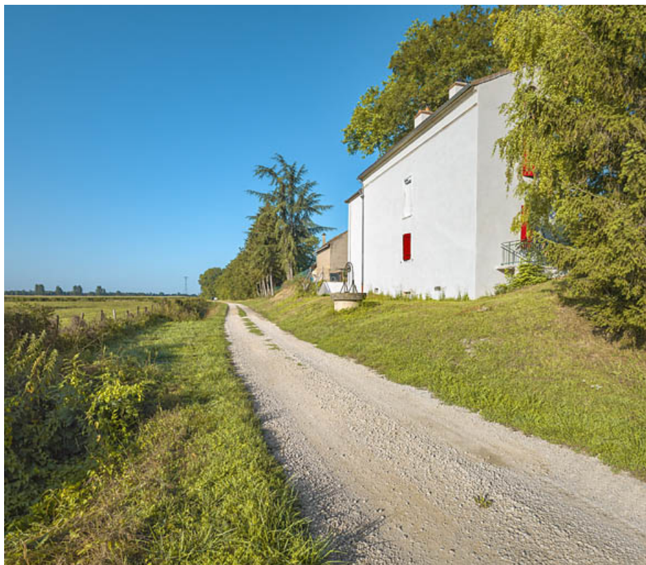
La maison éclusière de 3/4 : pignon, face arrière et puits.
