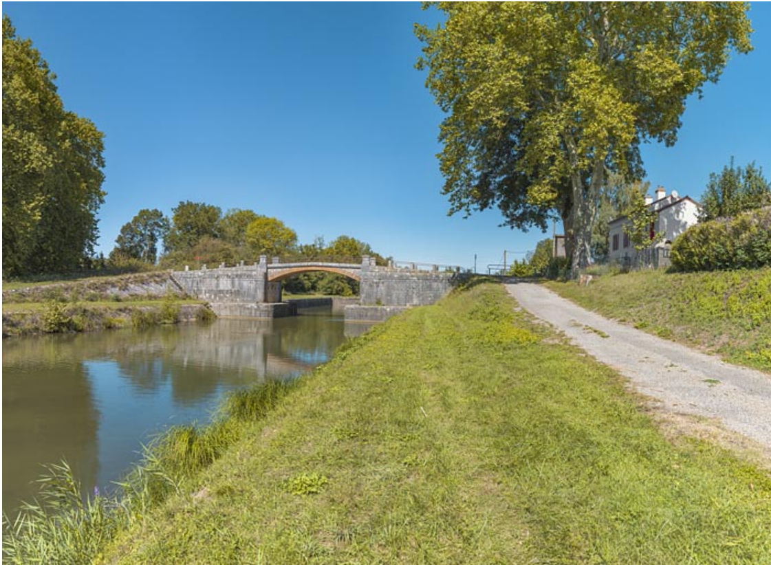
Vue d'ensemble du site, d'aval avec, à droite, la maison éclusière. 21, Trugny, lieudit : PK 184
