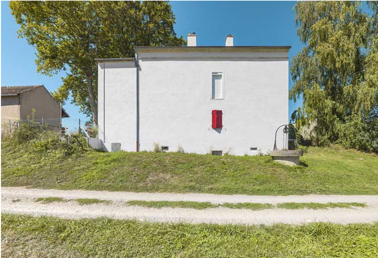
La maison éclusière : face arrière.
