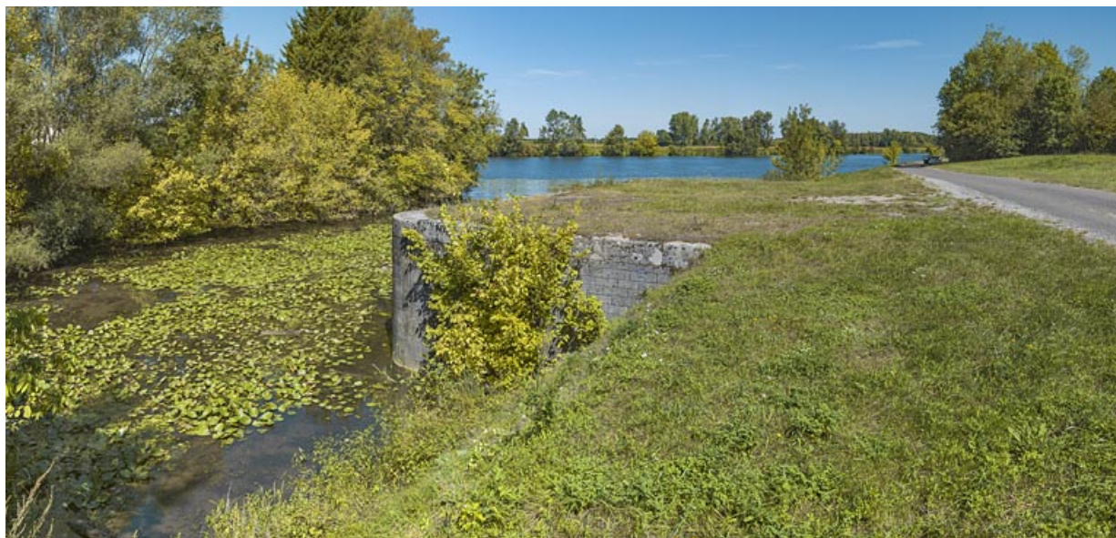
Les vestiges de la porte de garde de l'ancienne dérivation de Seurre. En arrière-plan, la Saône.
