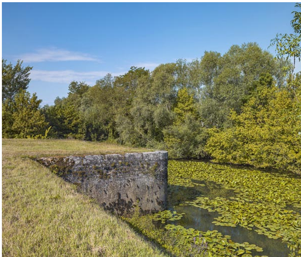
Les vestiges de la porte de garde de l'ancienne dérivation de Seurre.
