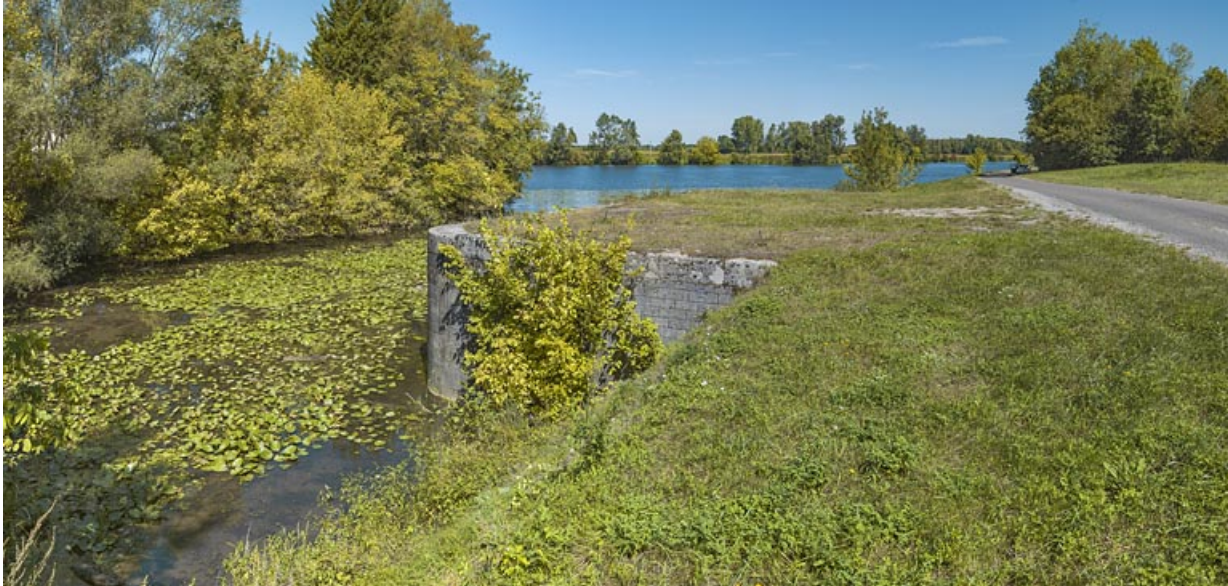
Les vestiges de la porte de garde de l'ancienne dérivation de Seurre. En arrière-plan, la Saône. 21, Trugny, lieudit : PK 185
