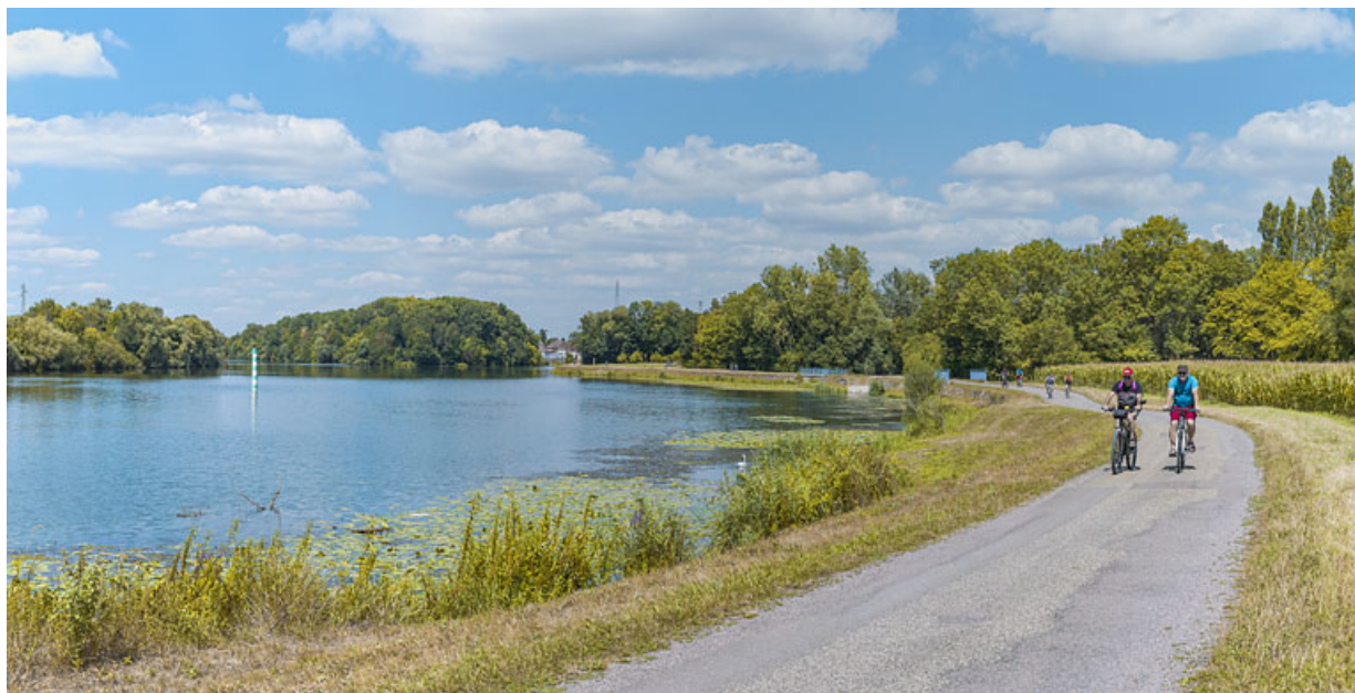
Vue d'ensemble d'aval des aménagements de rive à hauteur de Jallanges. En arrière-plan, la ville de Seurre. 21, Jallanges, lieudit : PK 186
