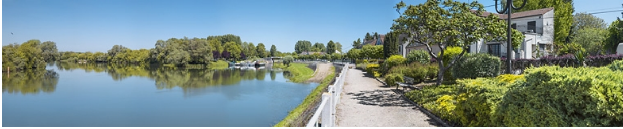
Vue d'ensemble depuis la digue de halage. A gauche, l'ancien lit de la Saône (hors dérivation). 21, Lechâtelet
