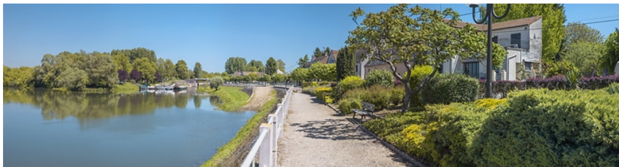
Vue d'ensemble de la digue de halage, en aval du site d'écluse et le long de la commune. 21, Lechâtelet
