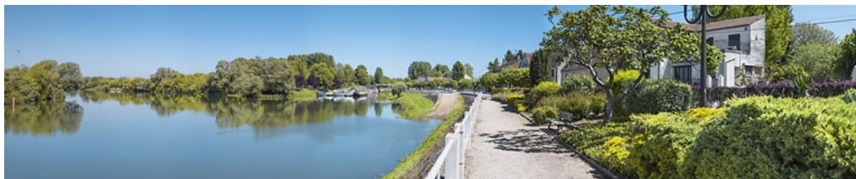
Vue d'ensemble depuis la digue de halage. A gauche, l'ancien lit de la Saône (hors dérivation).
