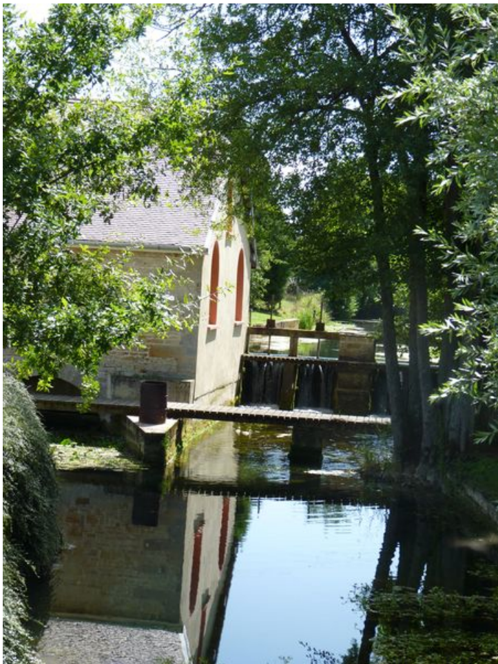
Vue du bief et des ouvrages associés au moulin ou à la forge.
