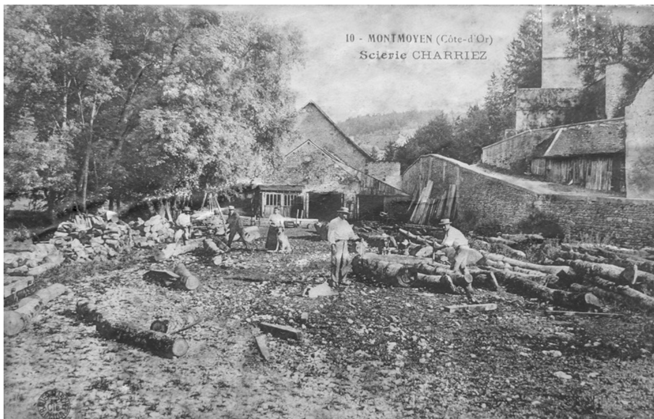
Carte postale ancienne montrant la partie nord du moulin, convertie en scierie. 21, Montmoyen, 2 rue de la Roche
