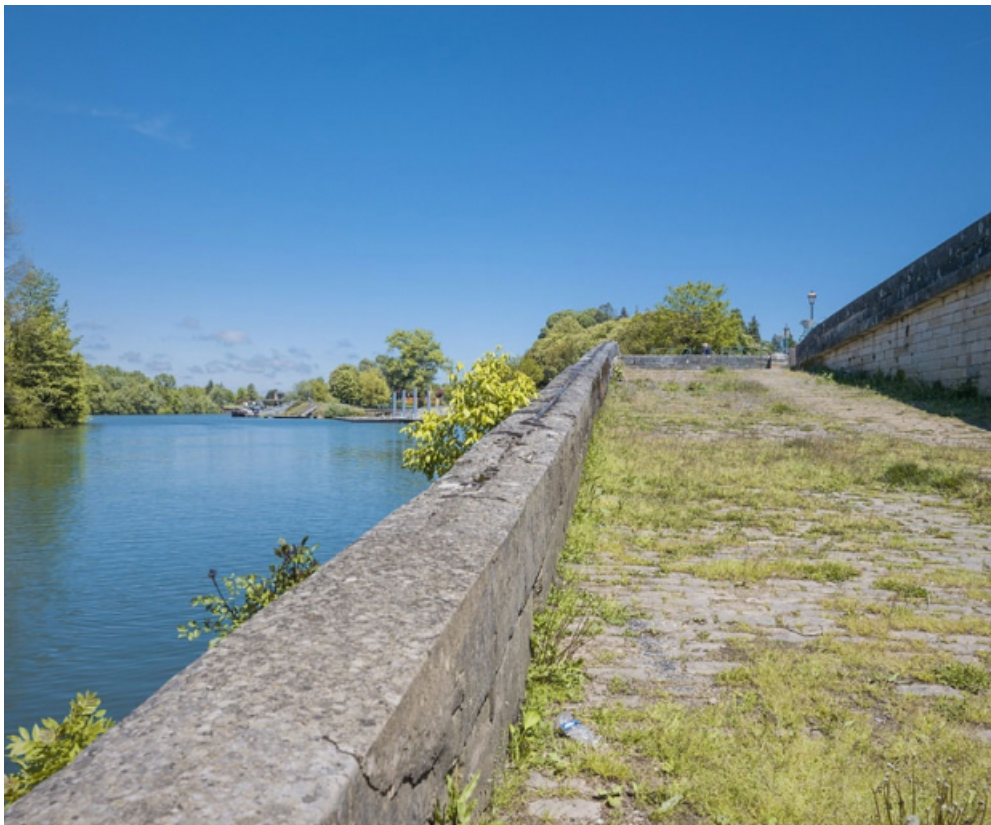
Rampe d'accès située juste en aval des quais à gradins.
