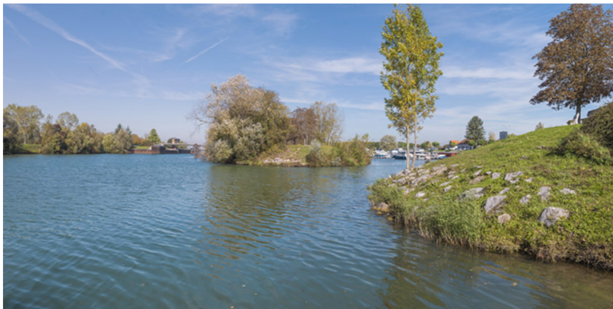
Chenal d'entrée dans le port et en arrière-plan le site d'écluse de Seurre.
