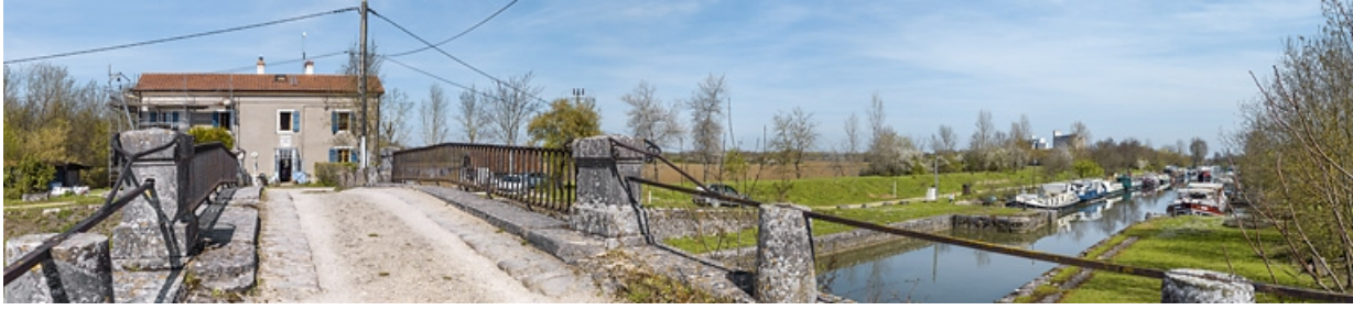
Vue du dessus avec le port (ancienne dérivation) à droite.
