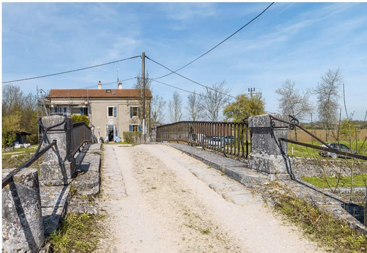
Vue du dessus. Détail des garde-corps.
