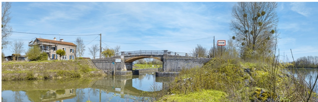
Vue d'ensemble d'aval : à gauche, la maison éclésièrè et à droite, la Saône. 21, Saint-Usage, lieudit : PK 211
