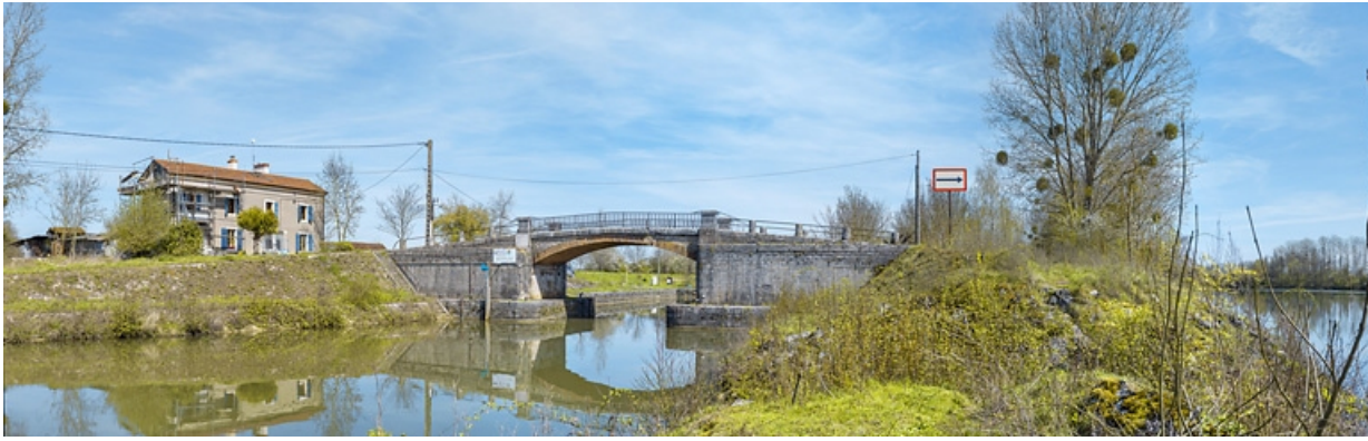
Vue d'ensemble d'aval : à gauche, la maison éclusière et à droite, la Saône. 21, Saint-Usage, lieudit : PK 211
