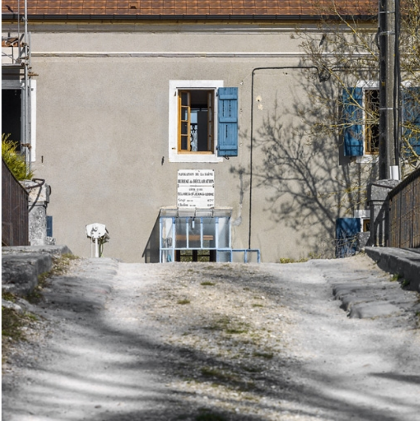
Maison éclusière : vue rapprochée sur la plaque.
