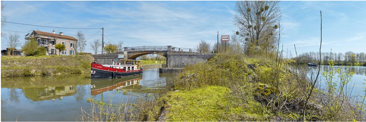
Vue d'ensemble d'aval : à gauche, la maison éclusière et à droite, la Saône. 21, Saint-Usage, lieudit : PK 211
