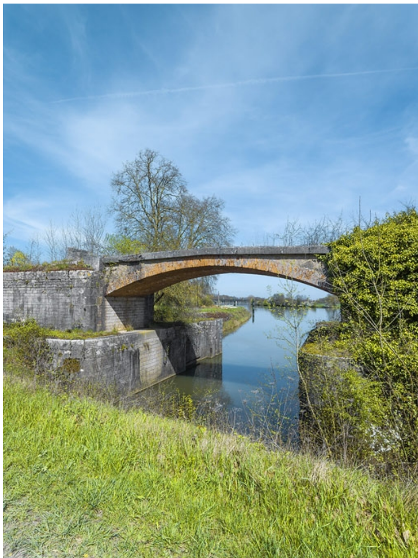
Vue d'ensemble. En arrière-plan le pont ferroviaire (IA21005578). 21, Saint-Usage, lieudit : PK 212
