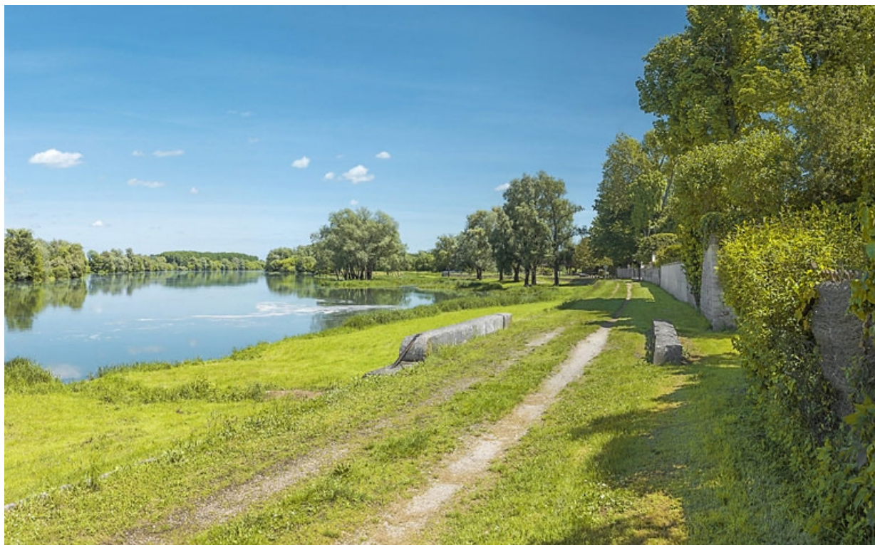
Le deuxième ponceau, vu d'aval.
