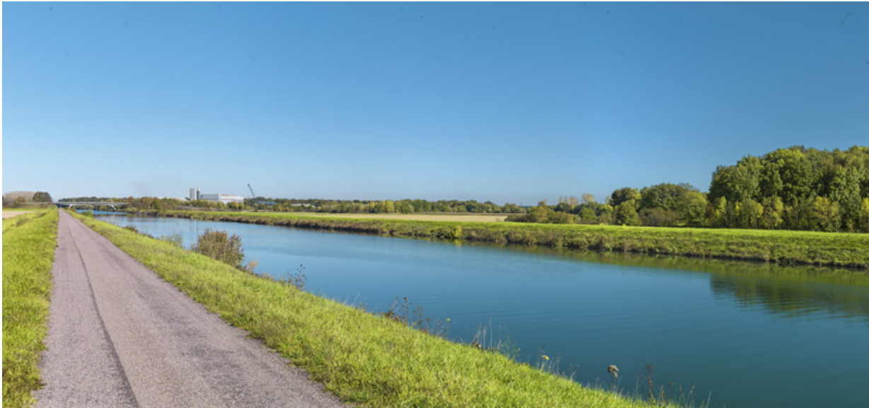
Vue d'ensemble de la dérivation au niveau du Technoport.
