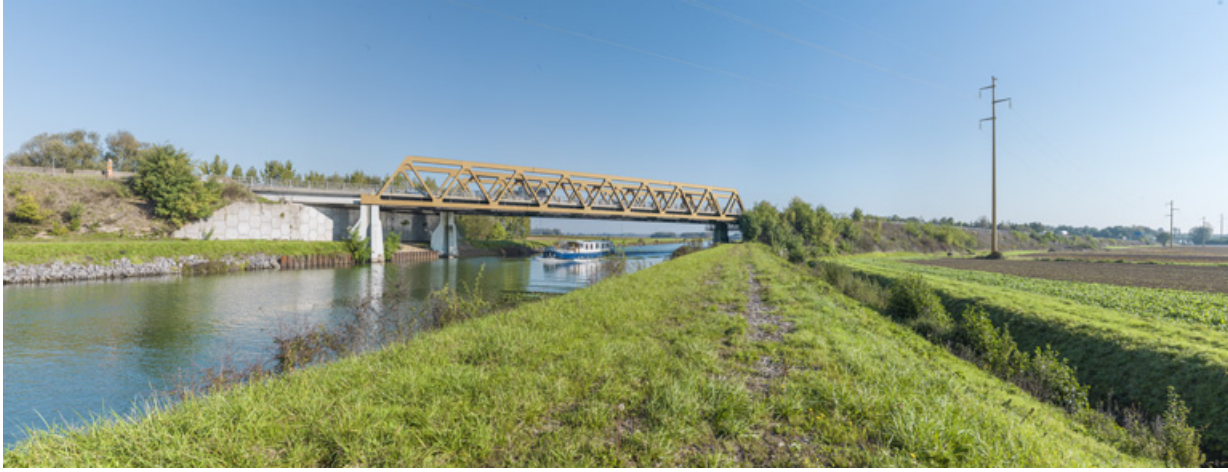
La Saône et le pont autoroutier de l'A36 franchissant la dérivation de Pagny-Seurre à Labruyère. 21, Seurre
