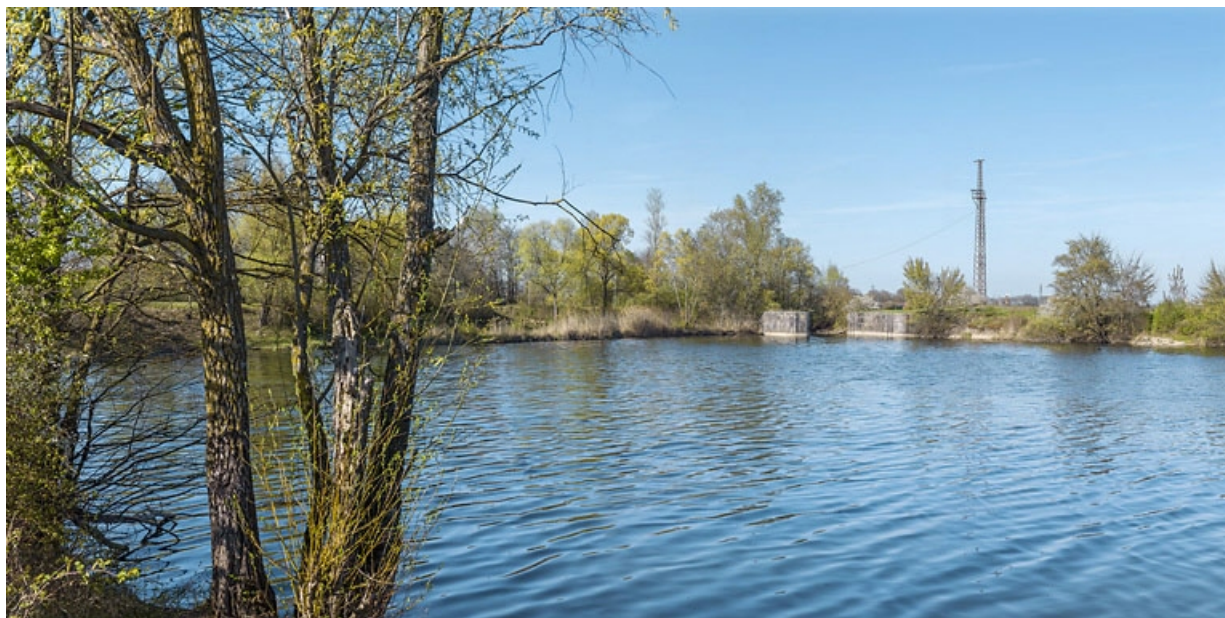
Les vestiges de l'ancien barrage de Saint-Jean-de-Losne au niveau de la digue. 21, Losne, lieudit : Chaugey
