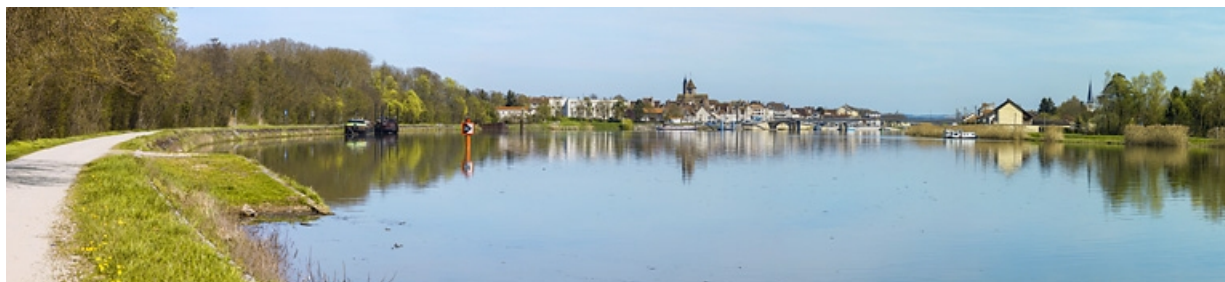
Vue d'ensemble de Saint-Jean-de-Losne, sur la rive droite de la Saône.
