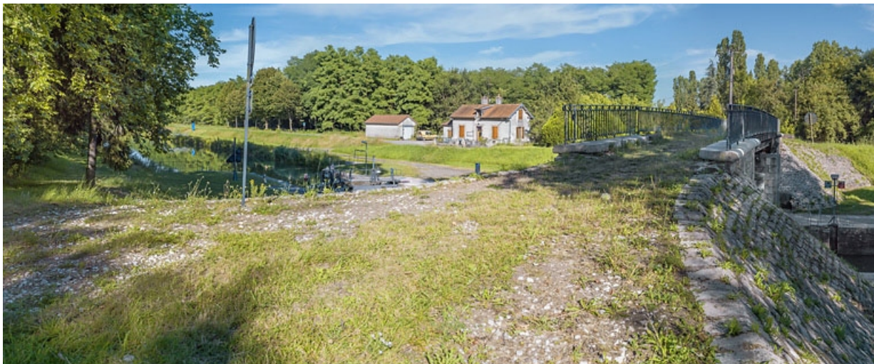
Vue d'ensemble. La maison éclusière en arrière-plan.
