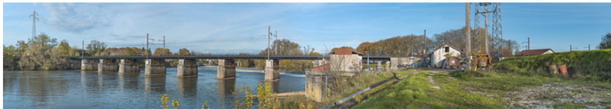
Le pont ferroviaire d'Auxonne (21).
