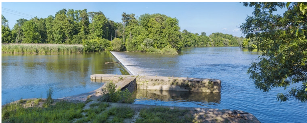
Vue d'ensemble du barrage avec le pertuis au premier plan.
