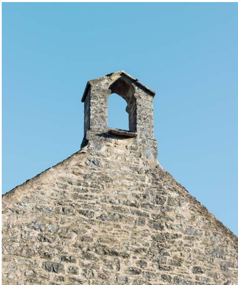
Détail du campanile.
