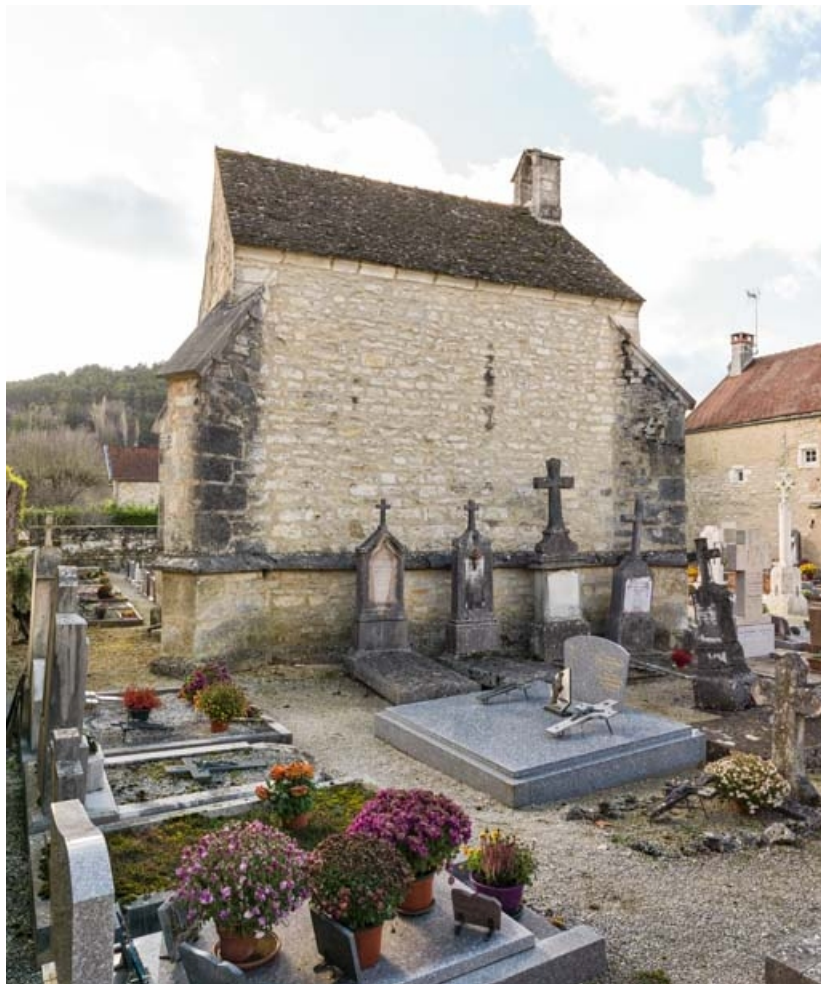
Vue de l'élévation latérale.
