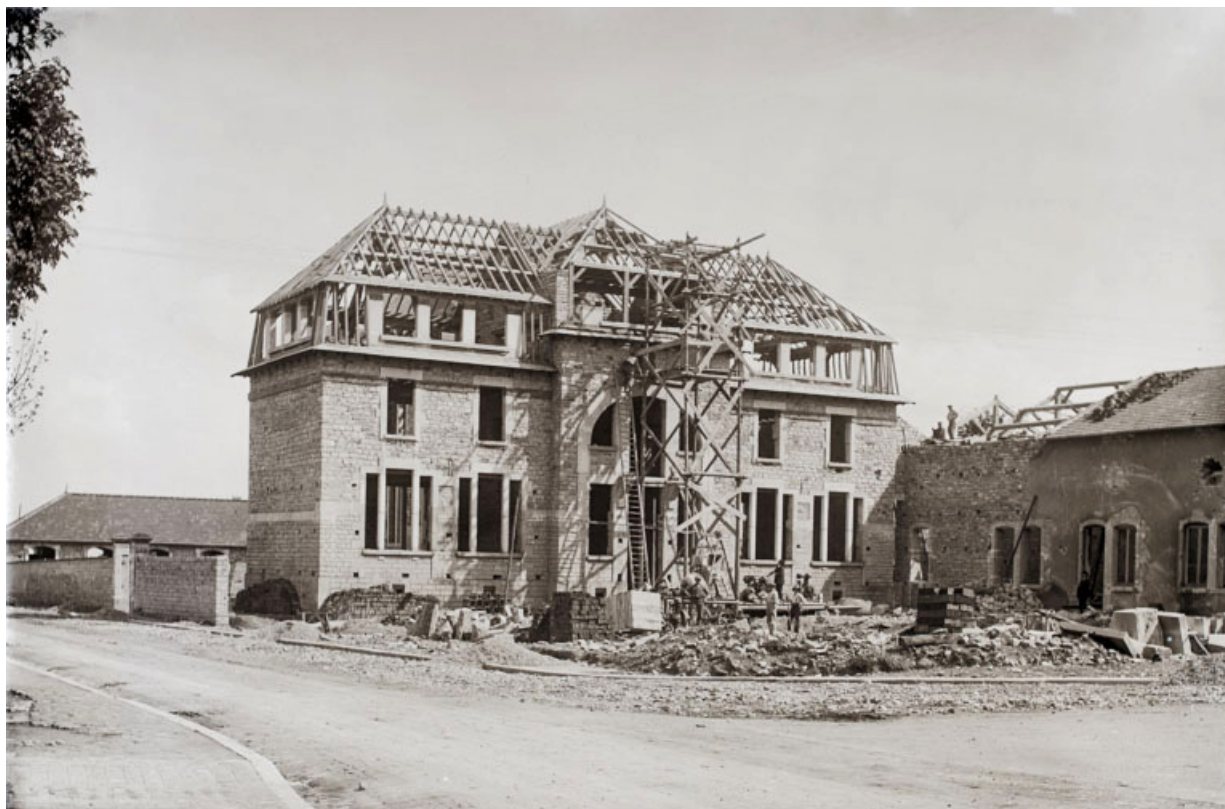
Nuits-Saint-Georges : construction de l'école des garçons. S.d. [entre 1926 et 1930]. A droite est visible l'extrémité du bâtiment, en cours d'extension.
