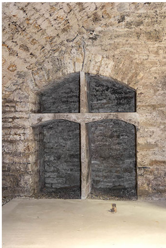
Cave : placard ménagé dans le mur. 21, Nuits-Saint-Georges, 5 rue Thurot
