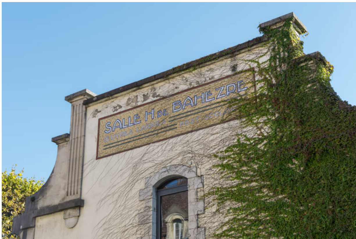
Façade antérieure, de trois quarts droite : partie supérieure avec inscription. 21, Nuits-Saint-Georges, 5 rue Thurot
