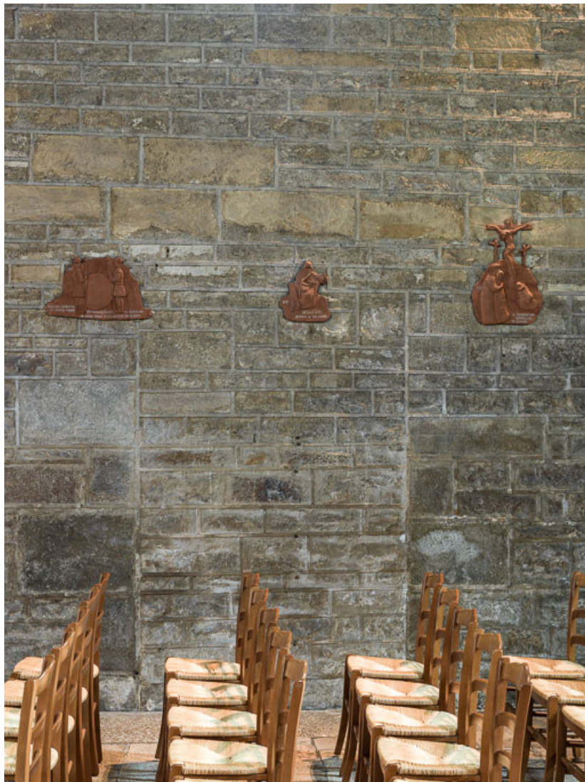
Porte murée, bras nord de la nef.
