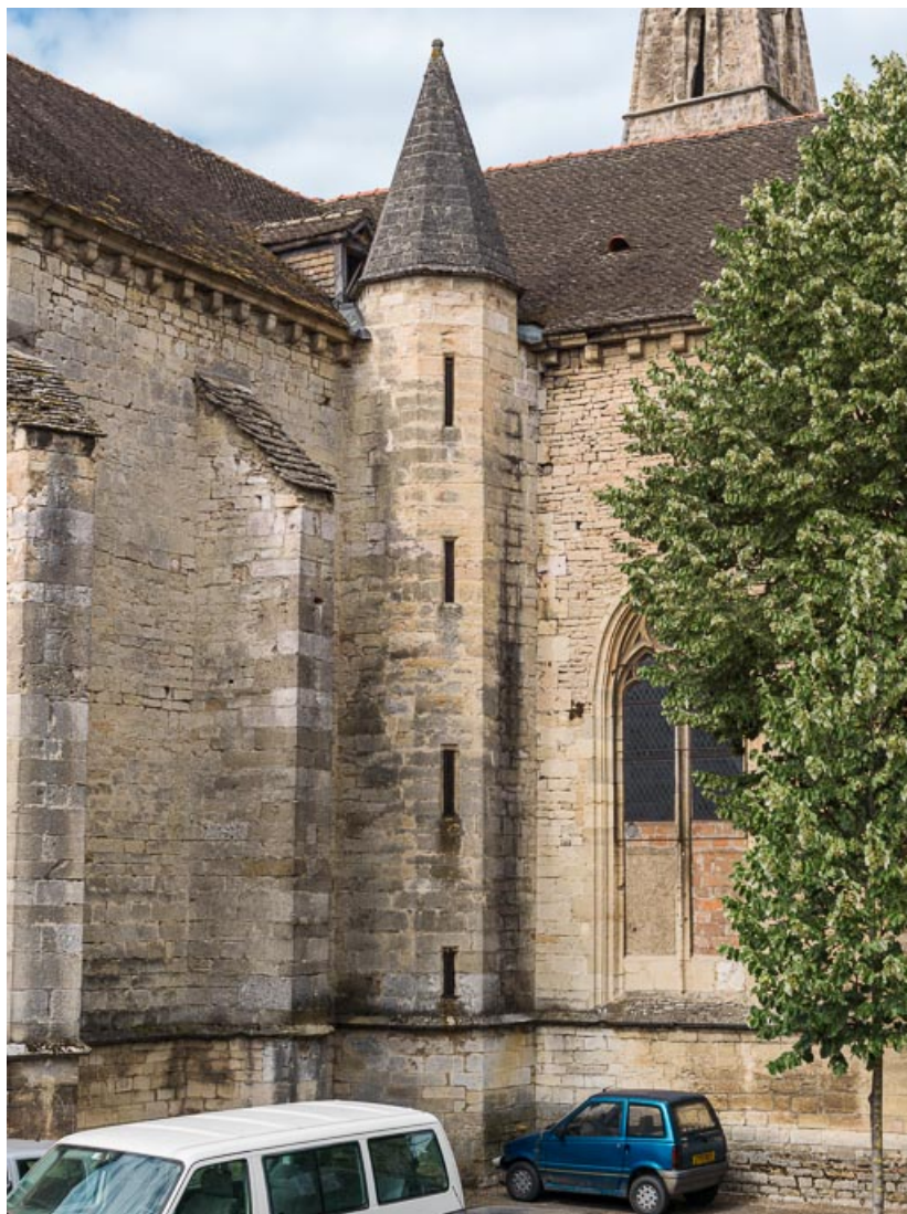
Vue de la tourelle d'escalier.
