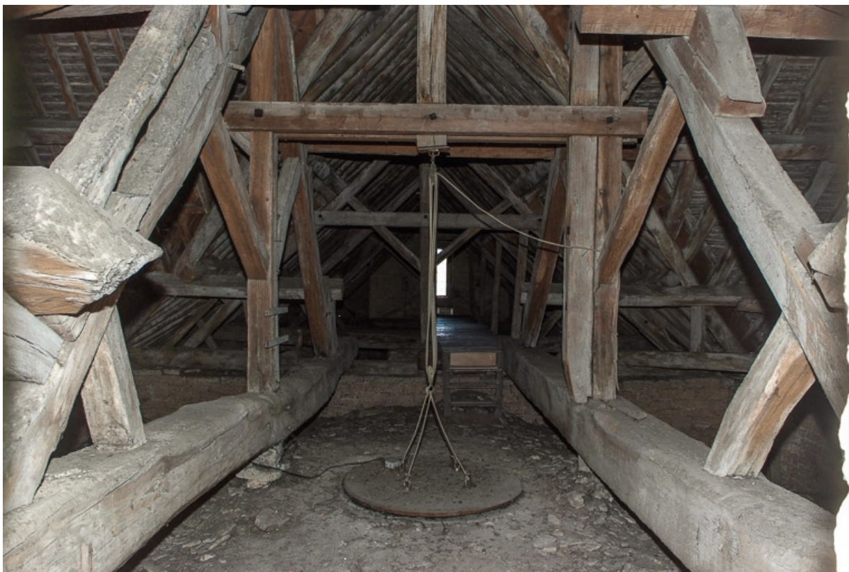
Combles, vue prise au-dessus de la croisée.
