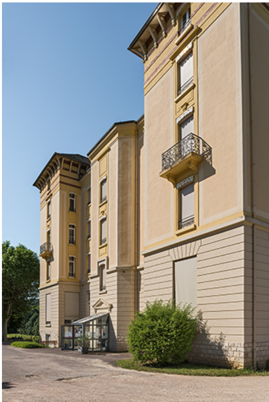
Façade nord-est avec l'entrée de l'escalier.
