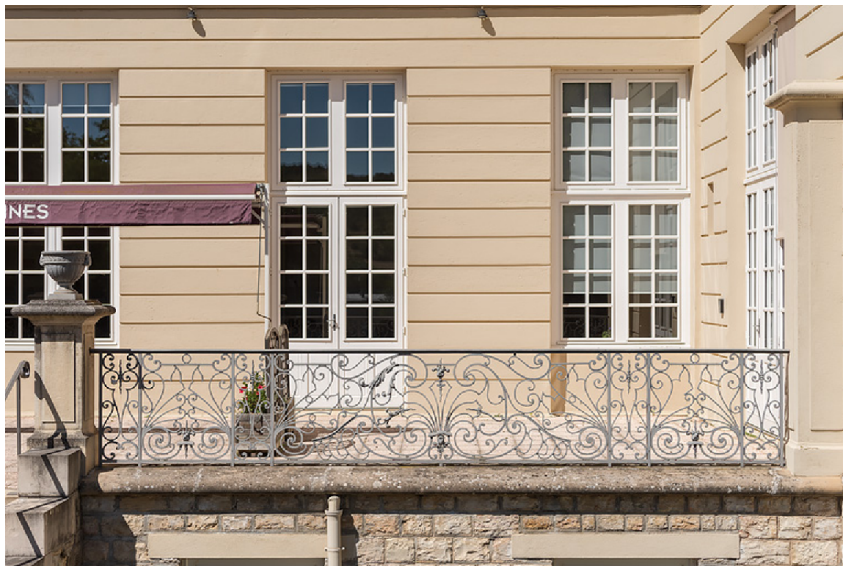
Garde-corps de la terrasse en façade principale, partie droite.
