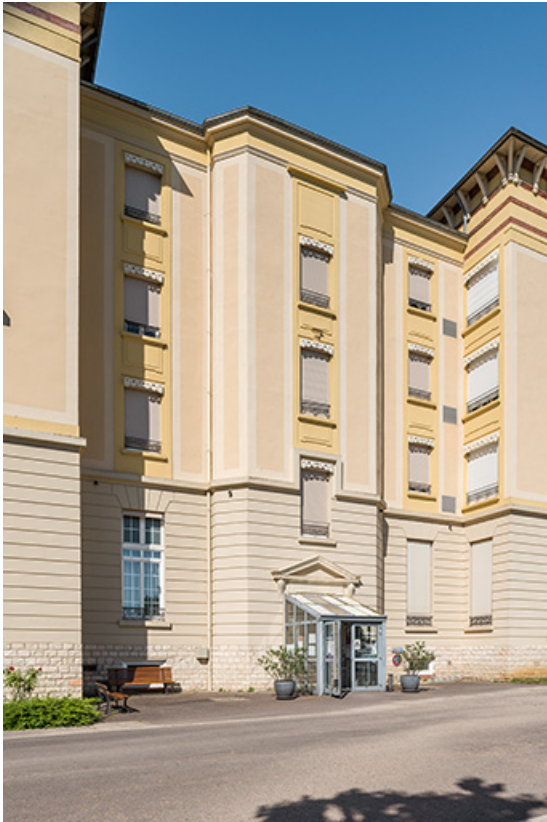
Façade nord-est avec l'entrée de l'escalier.
