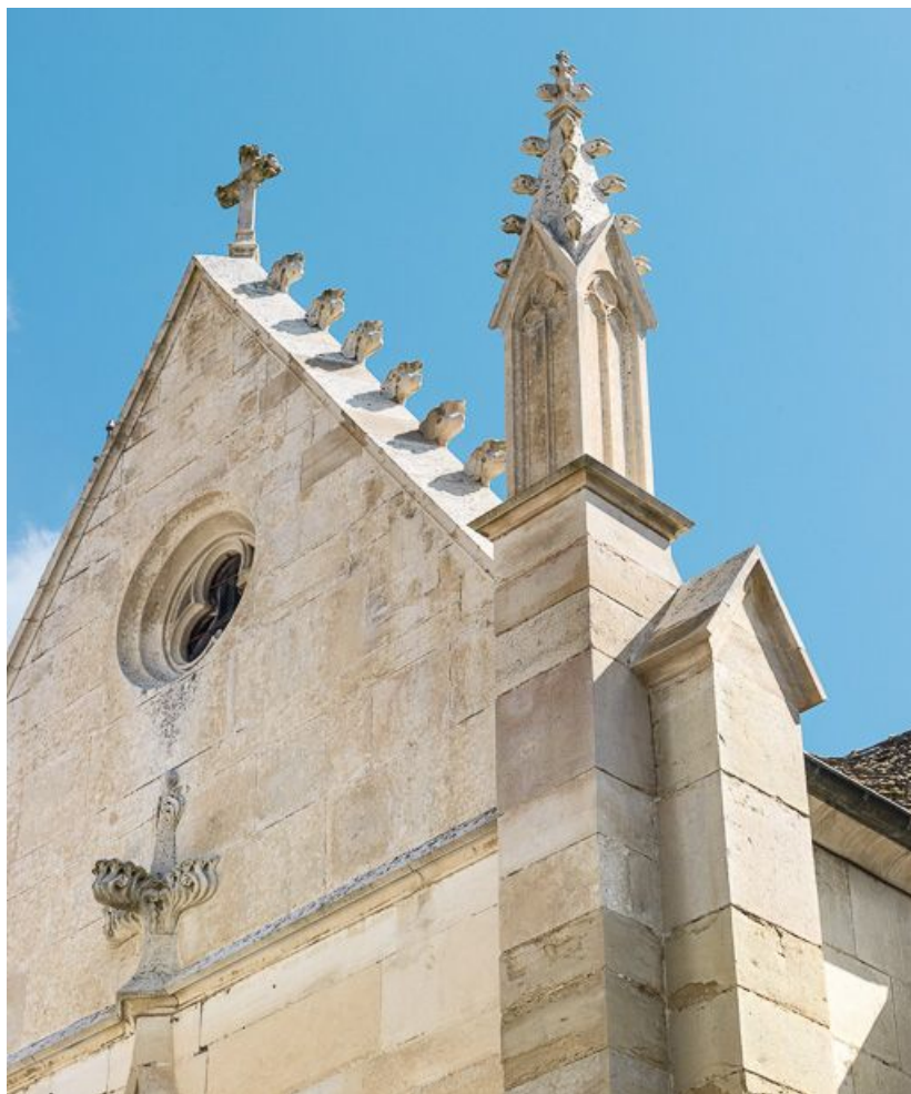
Façade: détail des pinacles et crochets.
