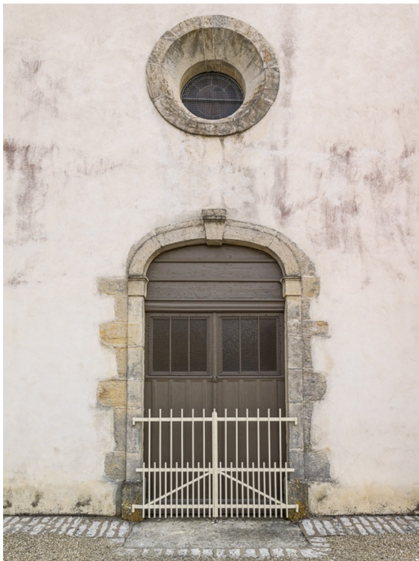
Façade, détail de la porte et de l'oculus.
