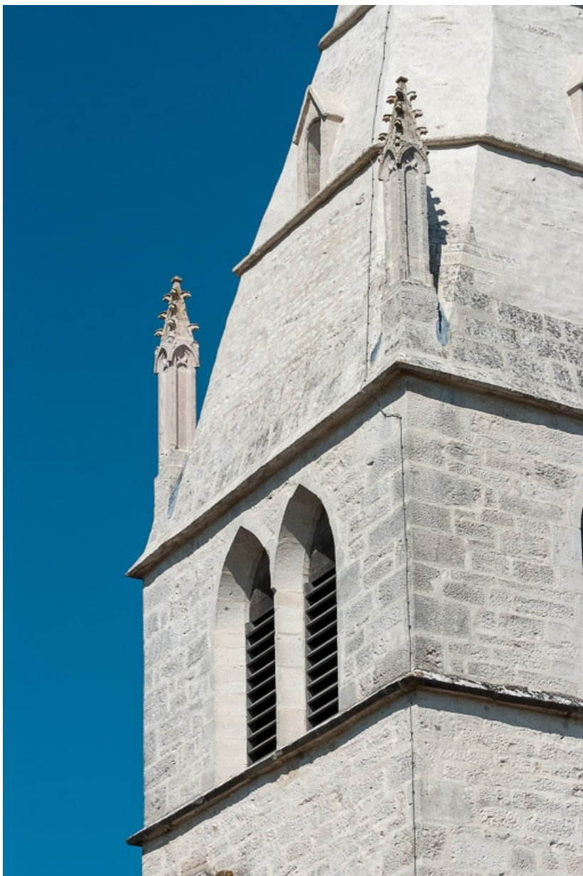
Clocher, détail des baies et des pinacles.
