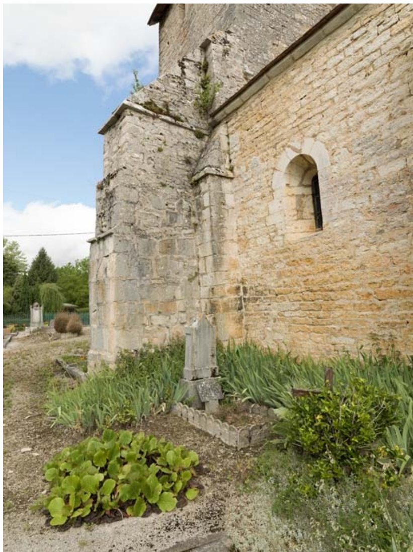
Contrefort à l'angle du clocher-porche et de la nef, élévation sud.
