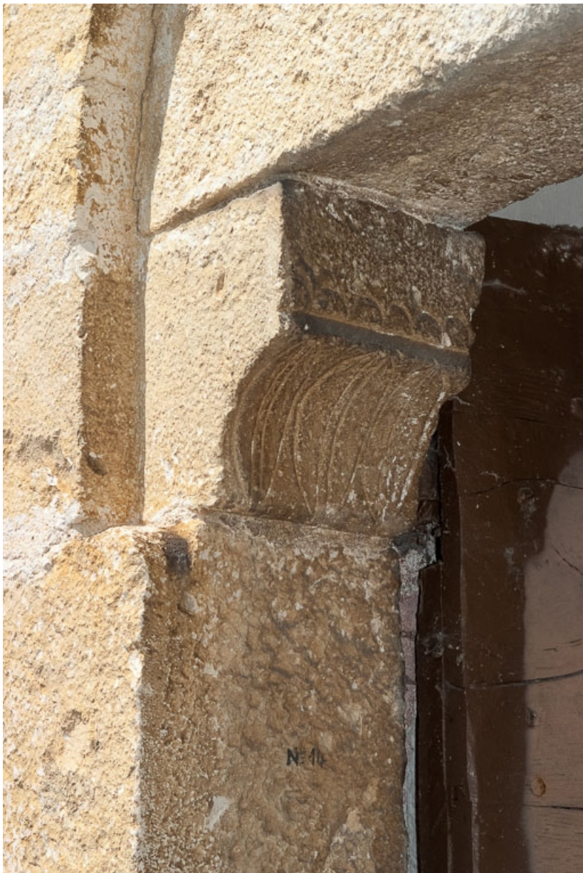
Porte latérale, détail d'un coussinet.
