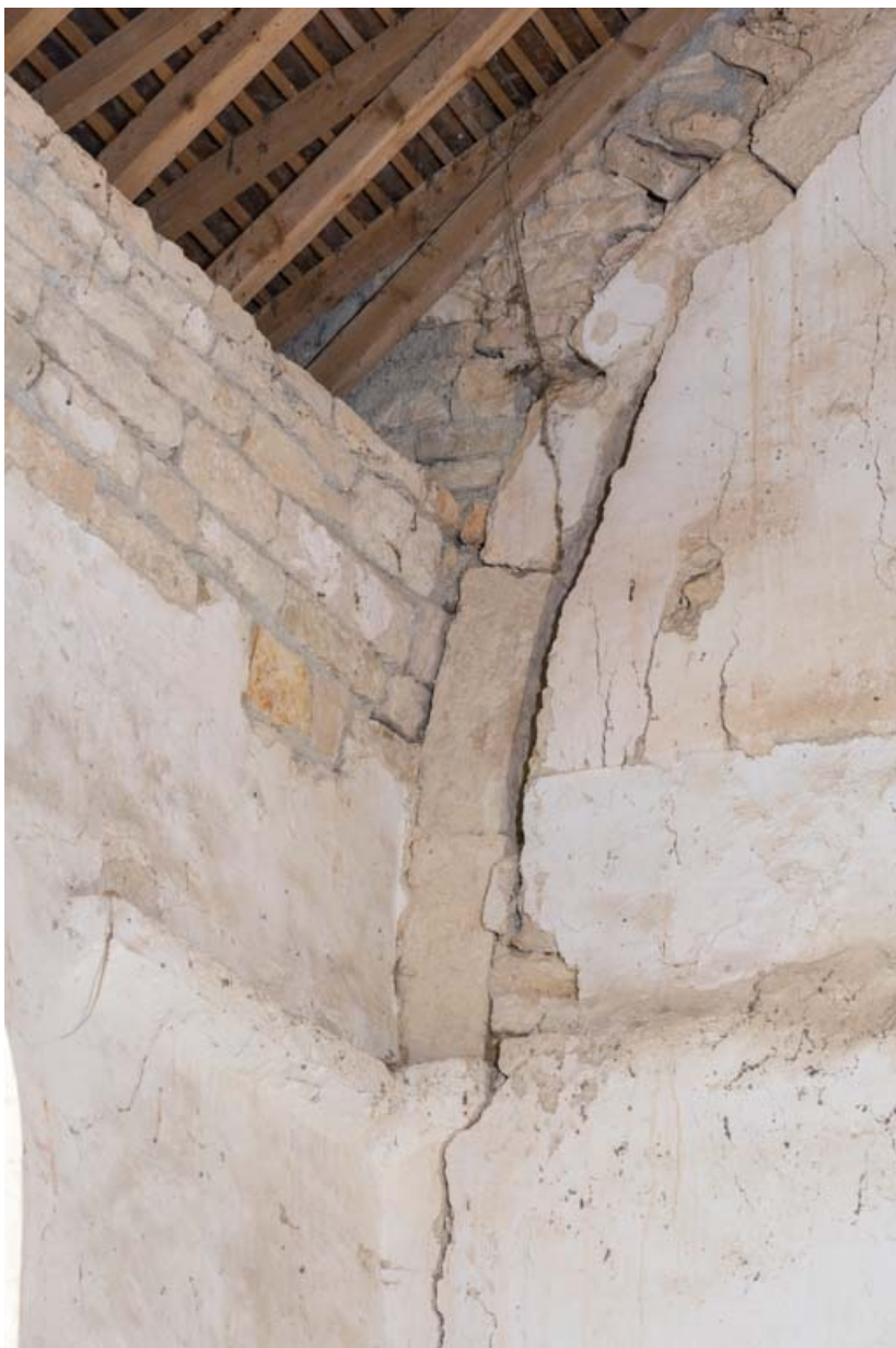
Détail du départ de voûte à l'angle sud-ouest de la nef. 21, Auxey-Duresses rue de la Fontaine, lieudit : Petit-Auxey
